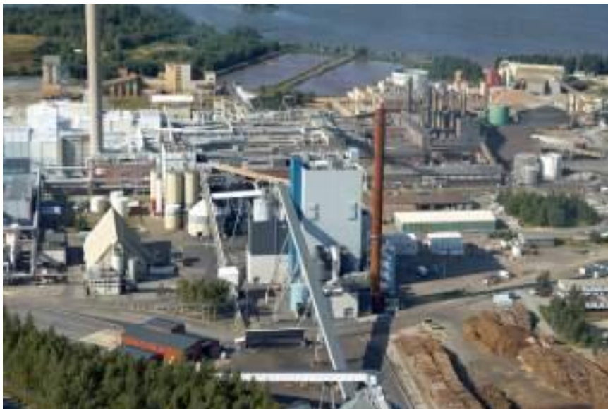
Kuva 3. Kaanaan voimalaitos. (Pori Energia Oy c, 2021)
