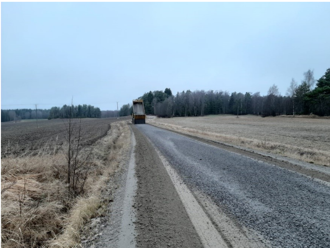
Kuva 4 Kulutuskerrosmateriaalin levitystä Haapasaarentiellä
