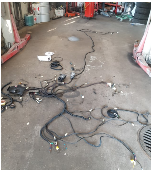
Kuva 2630 . Valmis johtosarja ennen asennusta.
