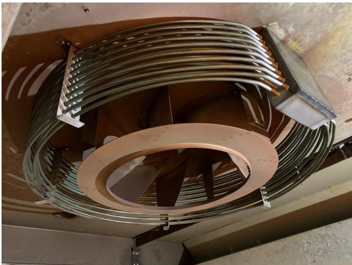
KUVA 27. Uusi lämmitysvastus asennettuna
