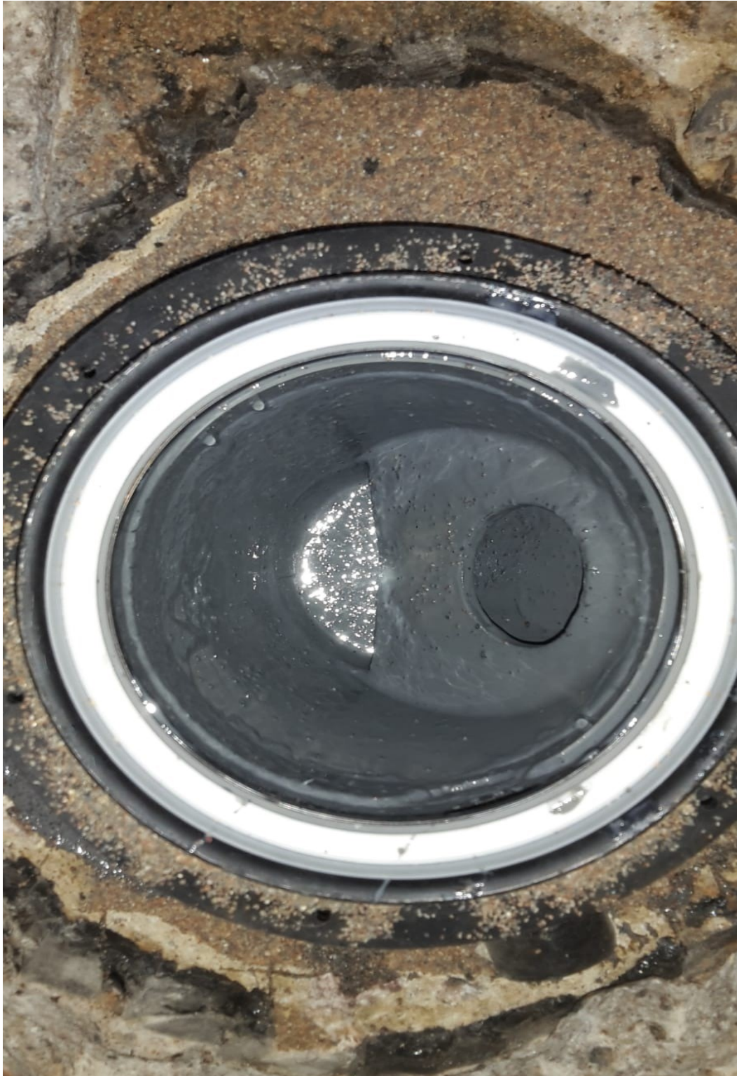
Kuva 16. Sama lattiakaivo pinnoituksen jälkeen. (kuva QL kohteesta)
