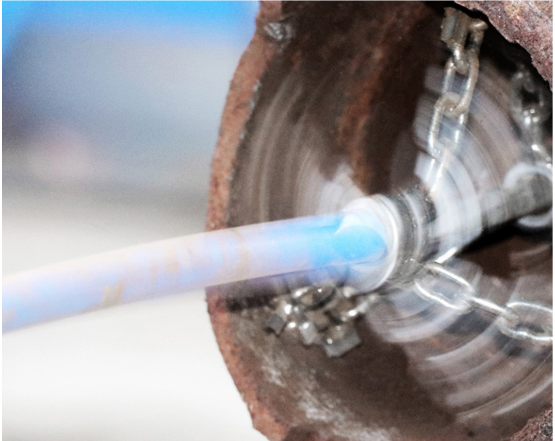
Kuva 8. Valurautaviemäriä puhdistetaan rassiketjulla (8).
