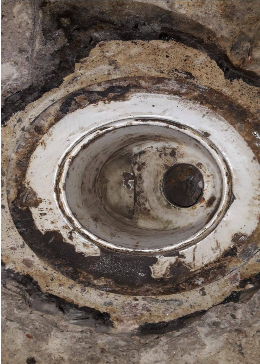
Kuva 15. Puhdistettu lattiakaivo ennen pinnoitusta. (kuva QL-kohteesta)
