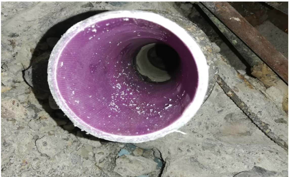
Kuva 10. Kuvan 6 putki sukituksen jälkeen. (Kuva QL-kohteesta)
