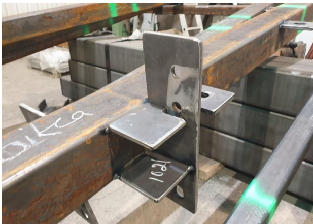
KUVA 4. Manuaalisesti viimeistelyjä levyosia silloitettuna ennen hitsausta.
