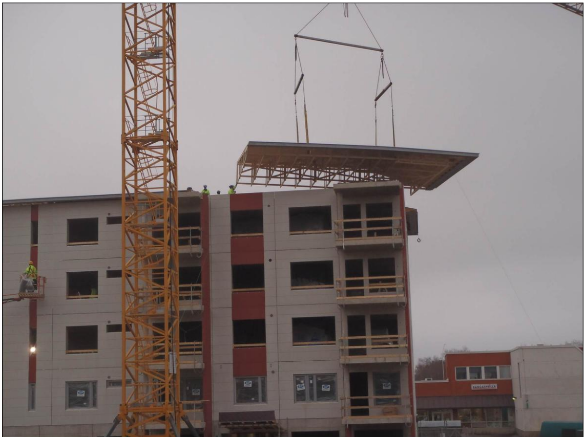
Kuva 1 As Oy Huittisten Keskushovi vesikattoelementin asennus
