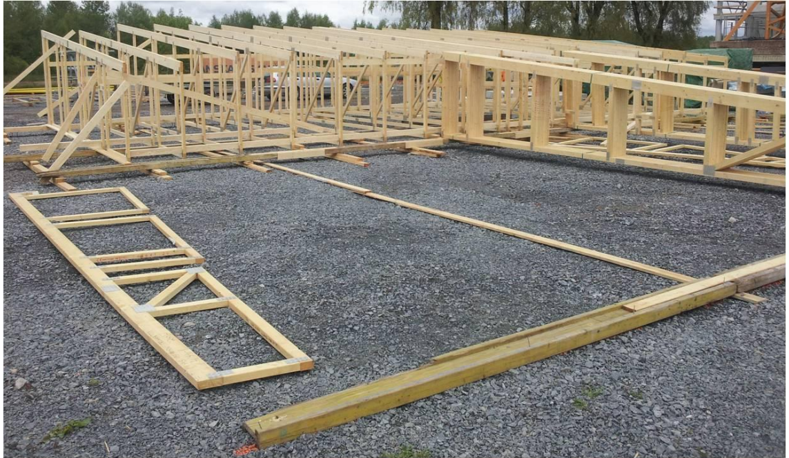
Kuva 13 Vesikaton puutyöt käynnissä.
