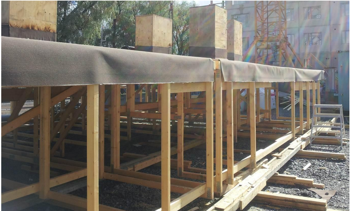
Kuva 14 Vesikattoelementtien saumoihin jätetty bitumihuovan liitosvarat.
