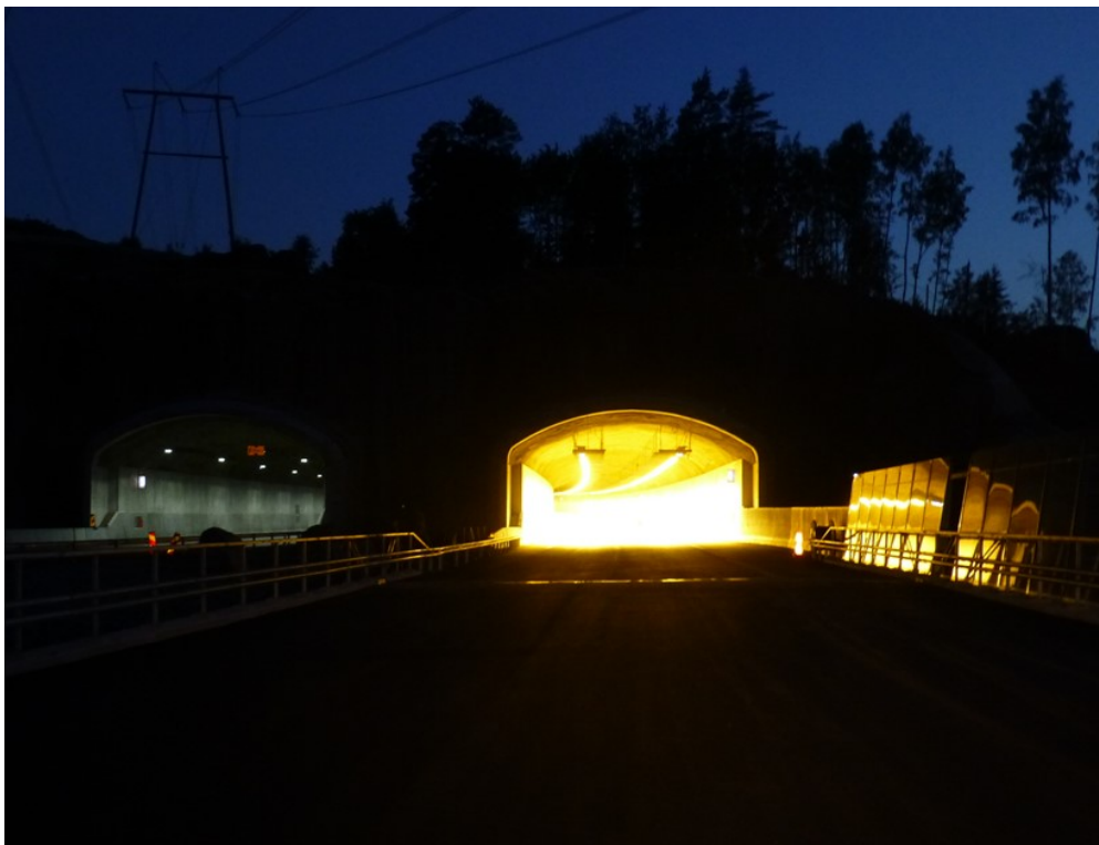
Kuva 8. Tunnelin valaistus yöllä, jos valaistusta ei ohjattaisi ja kaikki valaisimet olisivat päällä. [7.]
