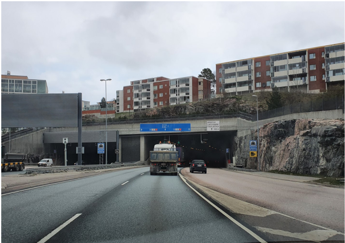
Kuva 3. Mestari-tunneli etelästä päin kuvattuna.
