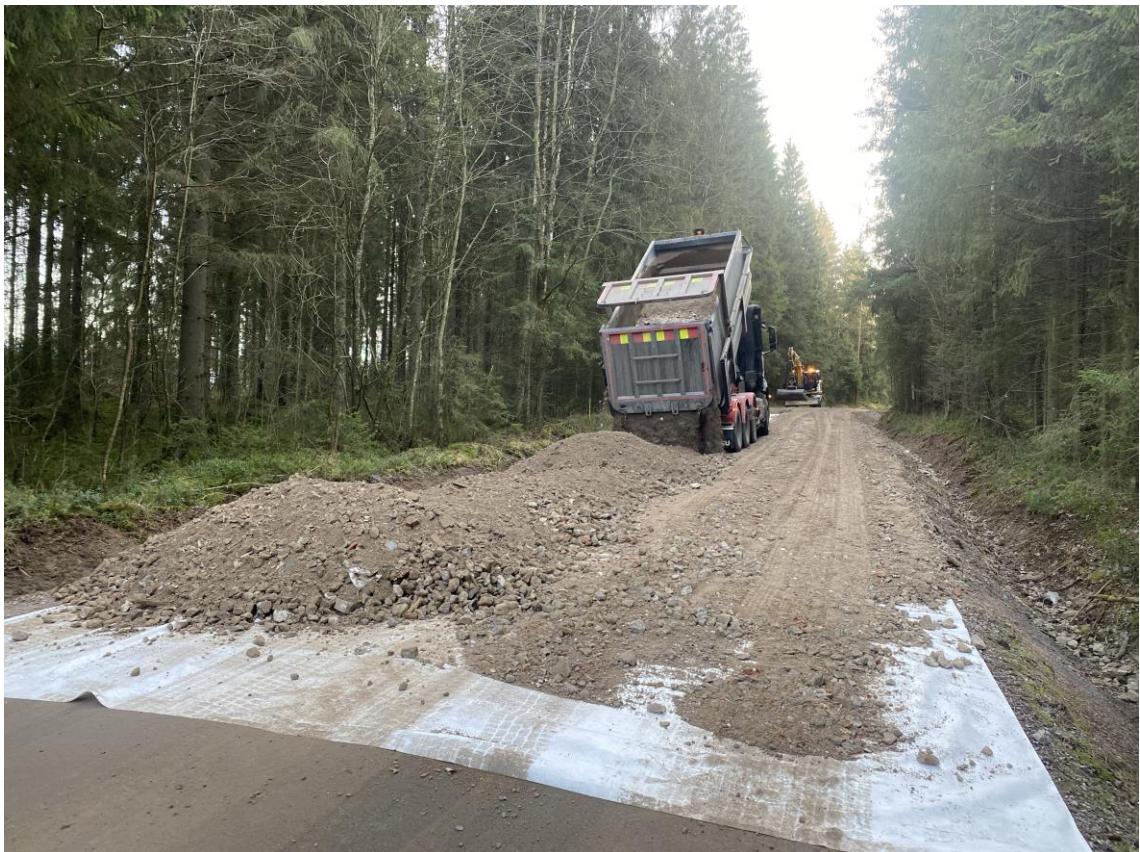
KUVA 9. 0/90 betonimurskeen levitystä.
