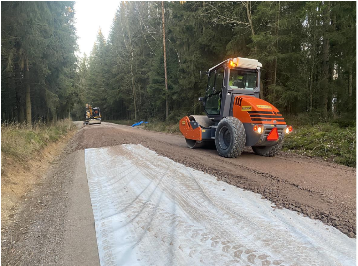
KUVA 6. Rakennekerrokset tiivistettiin valssijyrällä. Koerakenne 3:n tiivistystä.
