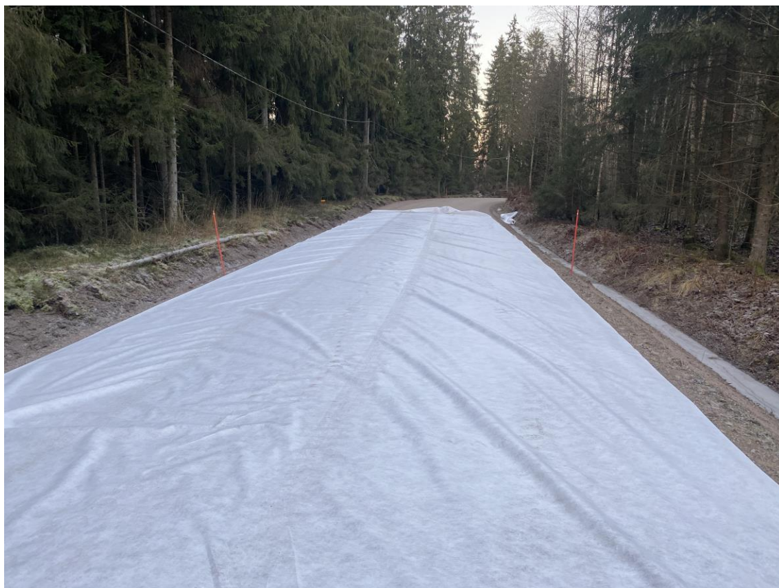
KUVA 4. Rakenteen alle levitettiin N3-suodatinkangas.
