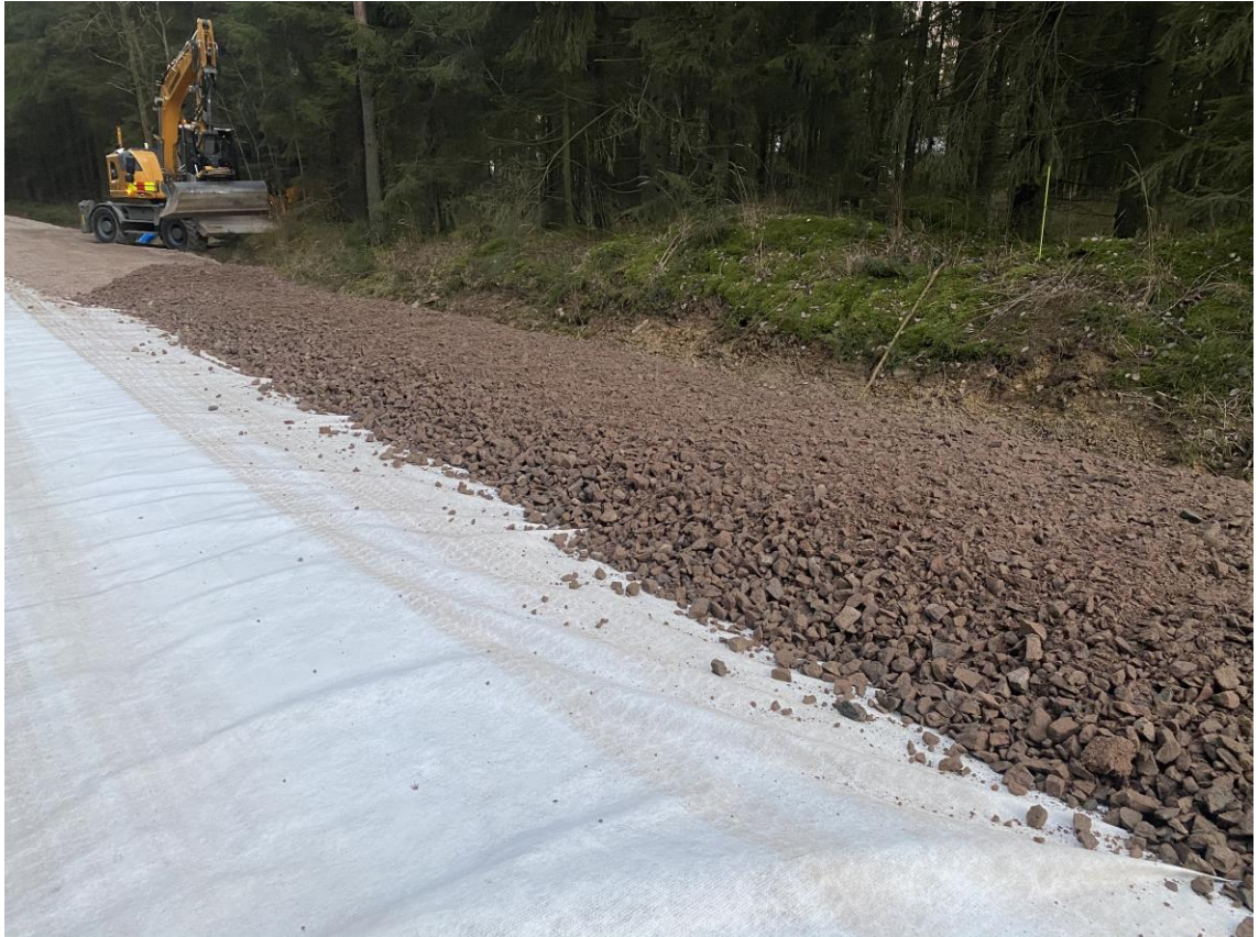
KUVA 11. 0/55 kalliomurskeen levitystä. Hienoainespitoisuus on betonimurskeeseen verrattuna pienempi.
