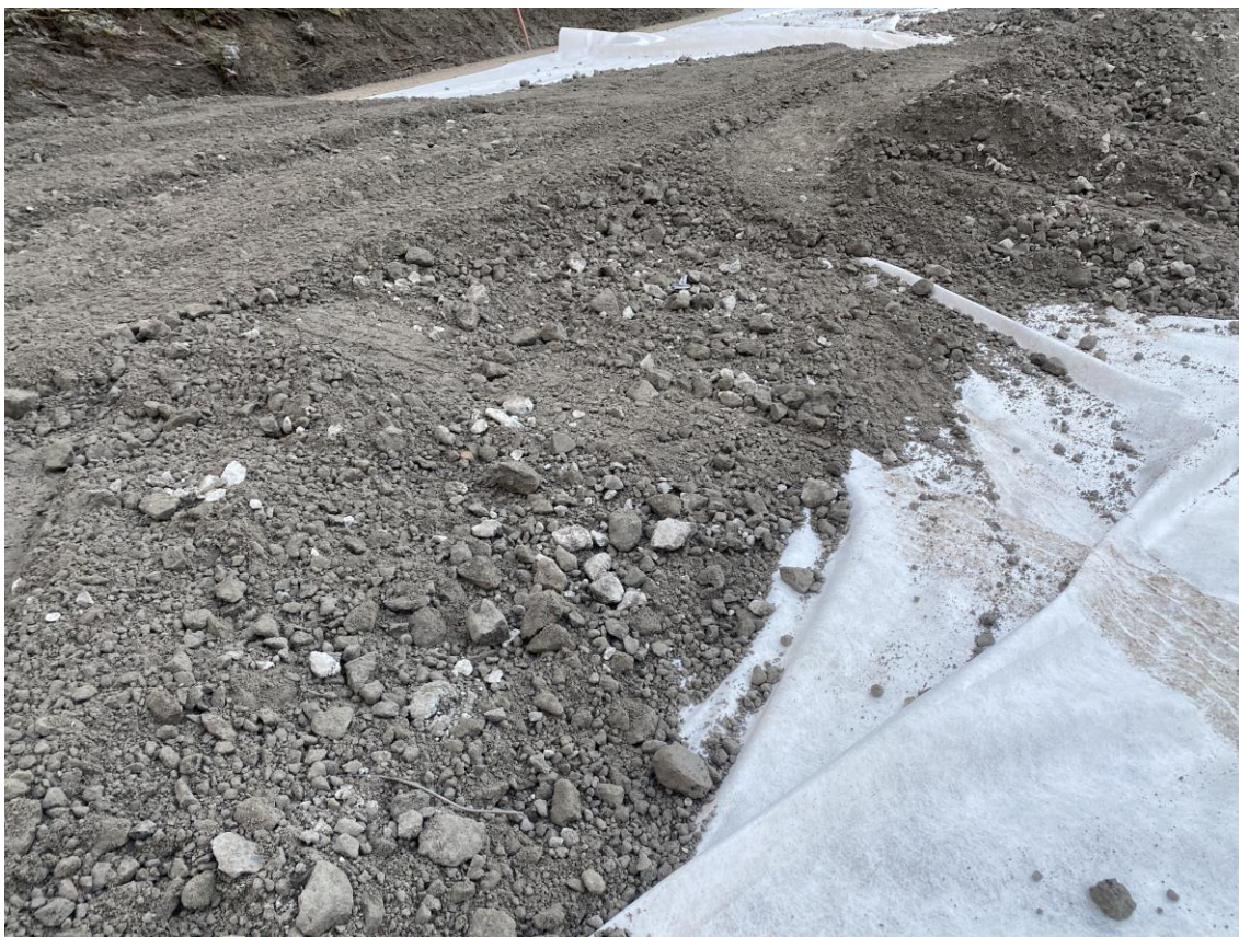
KUVA 7. 0/45 betonimurskeen levitystä.
