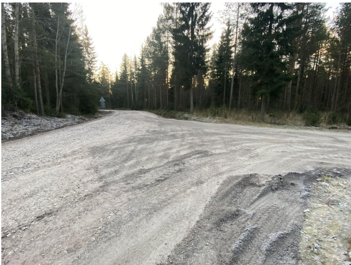
KUVA 5. Soratien kulutuskerros tiivistettynä.
