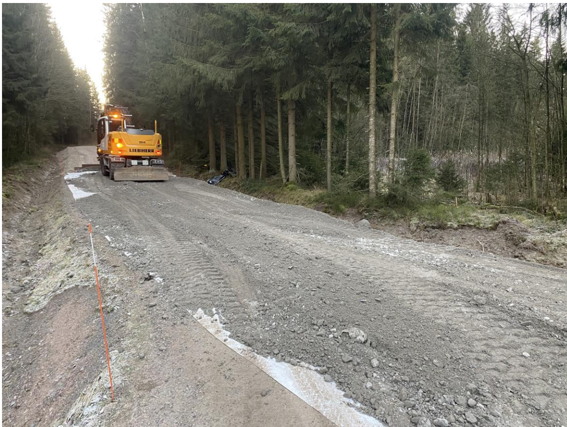
KUVA 7. 0/45 betonimurskeen levitystä.
