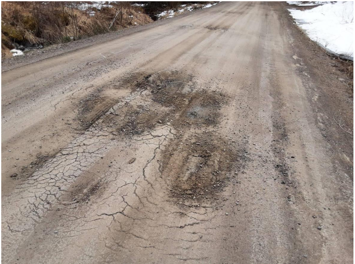
KUVA 1. Runkokelirikko soratiellä.
