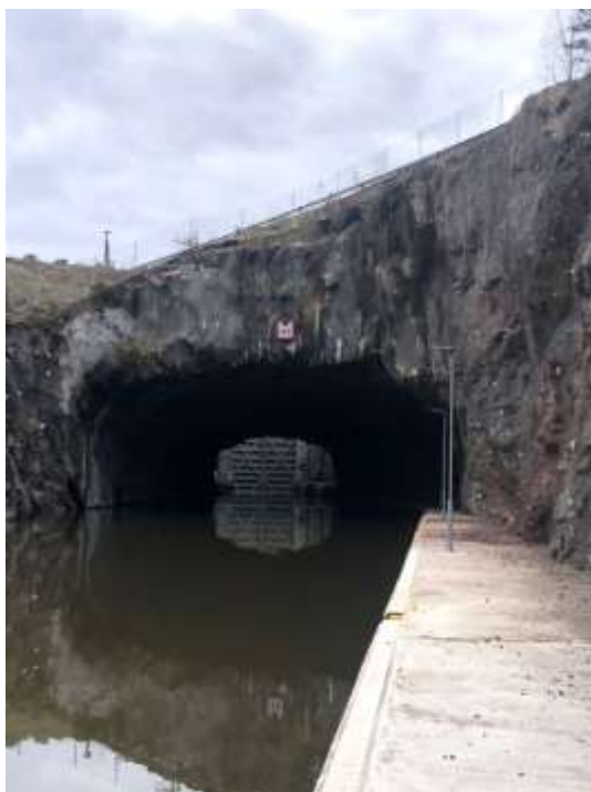
Kuva 11. Kallioinen uittotunneli kunnostettuna
