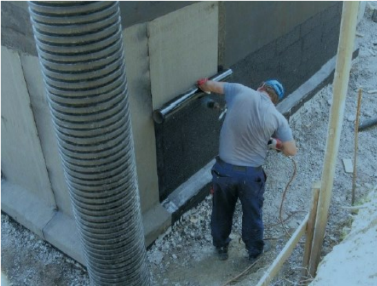
Kuva 2. Maanpaineseinän vedeneristyksen tekoa (RT 83-10955, 2009, s.1)
