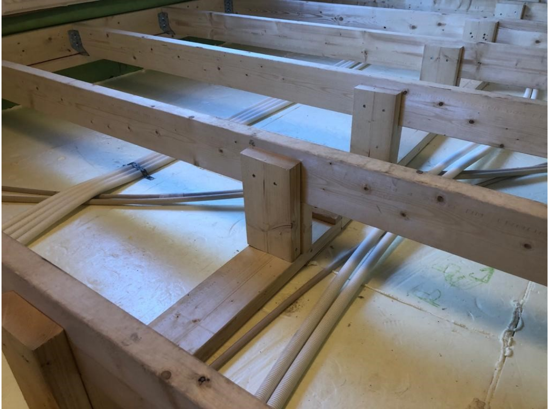
Kuva 11. Laajennusosan lattian runkoa.
