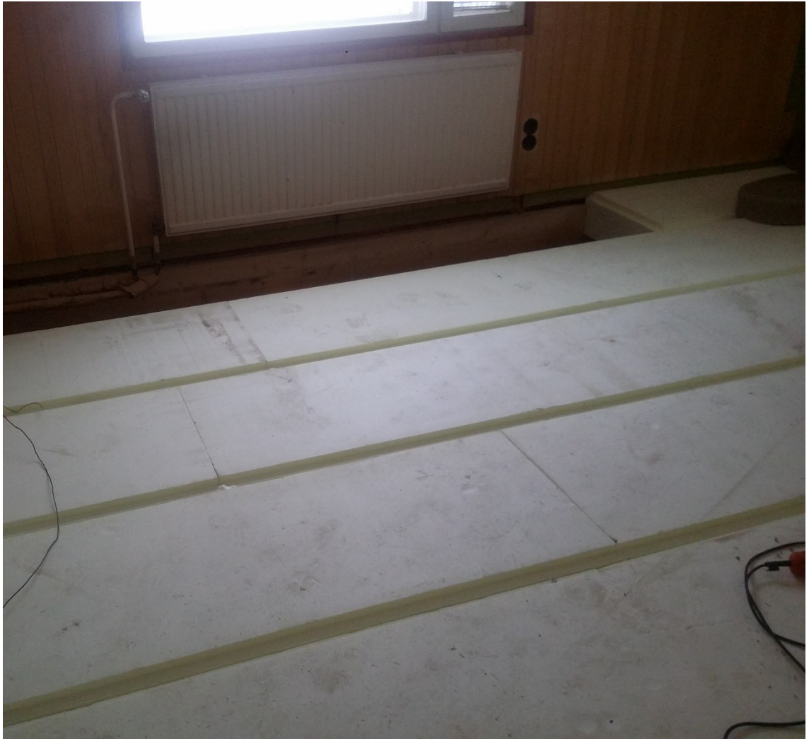
Kuva 9. Lattian lämmöneristeenä 210mm paksu Finnfoam-eristelevy.
