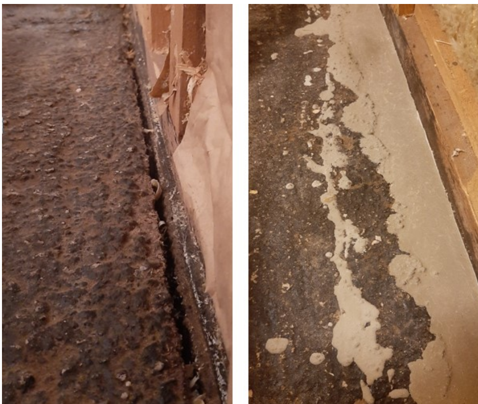
Kuva 10. Ulkoseinien vieressä olevien rakojen juotosvalu.
