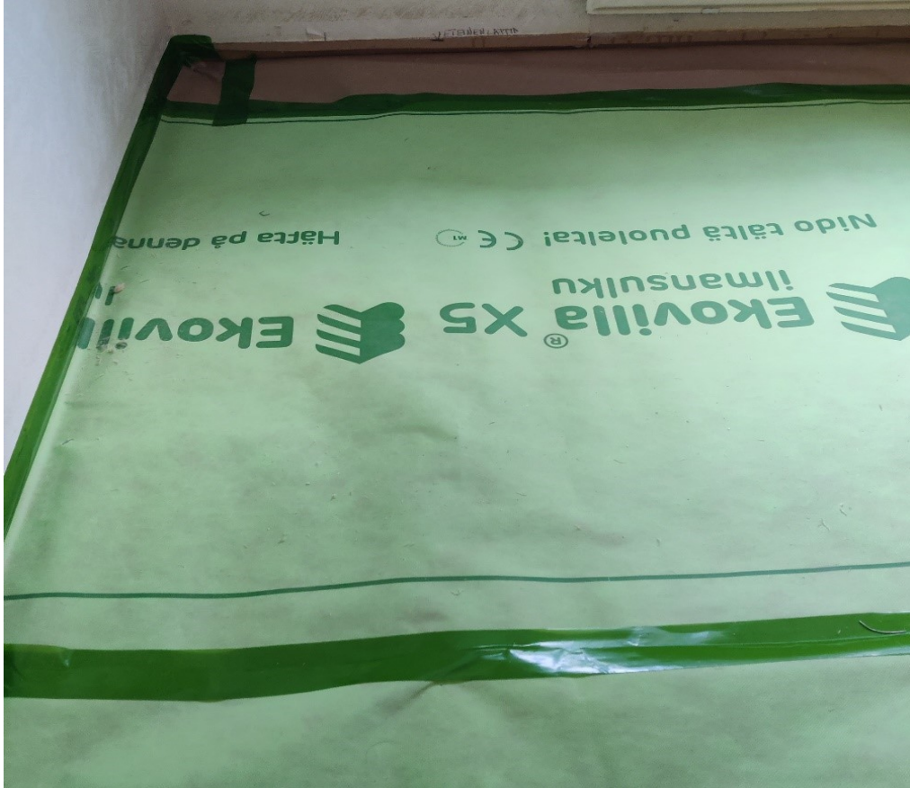
Kuva 14. Ilmansulkupaperi uuden lattiarungon päällä, jonka päälle asennettiin lattialas-tulevy.
