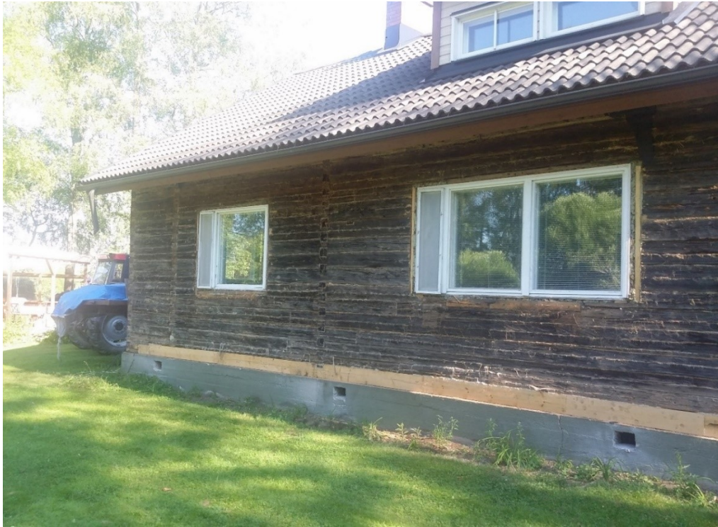
Kuva 7. Kesällä 2018 tehtiin julkisivuremontti. Kuvassa näkyy vaihdettu alimmainen hirsi sekä uudet tuuletusluukut.
