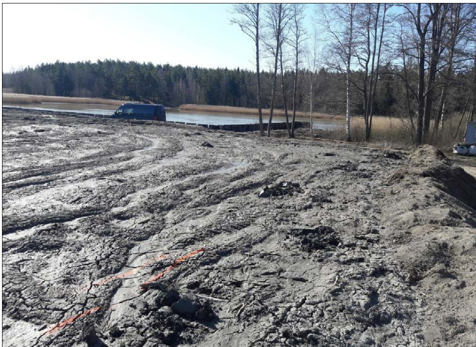
Kuva 17. Kenttäkokeeseen osoitettuun ruoppausaltaaseen läjitetty ruoppausmassa ennen tuhkan ja sideaineiden sekoittamista.
