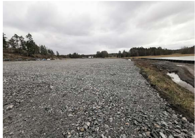
Kuva 78. Matalahden koekenttä 23.4.2021. Alue on tasattu ja peitetty murskekerroksella. Kenttä asfaltoidaan, ja sen päälle tulee tulevan asuinalueen pienvenesatamaa palveleva parkkipaikka.
