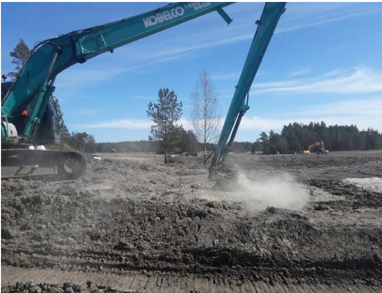
Kuva 20. Sideaineiden sekoitusta koeruutuun kaivinkoneen jrsijäpäällä.
