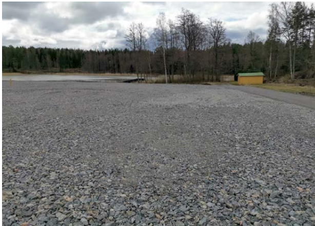
Kuva 78. Matalahden koekenttä 23.4.2021. Alue on tasattu ja peitetty murskekerroksella. Kenttä asfaltoidaan, ja sen päälle tulee tulevan asuinalueen pienvenesatamaa palveleva parkkipaikka.
