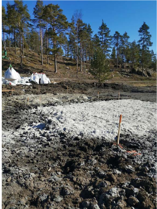
Kuva 19. Sideaineen levitys suursäkistä (vasemmalla) ja koeruutu sideaineiden lisäyksen jälkeen (oikealla).
