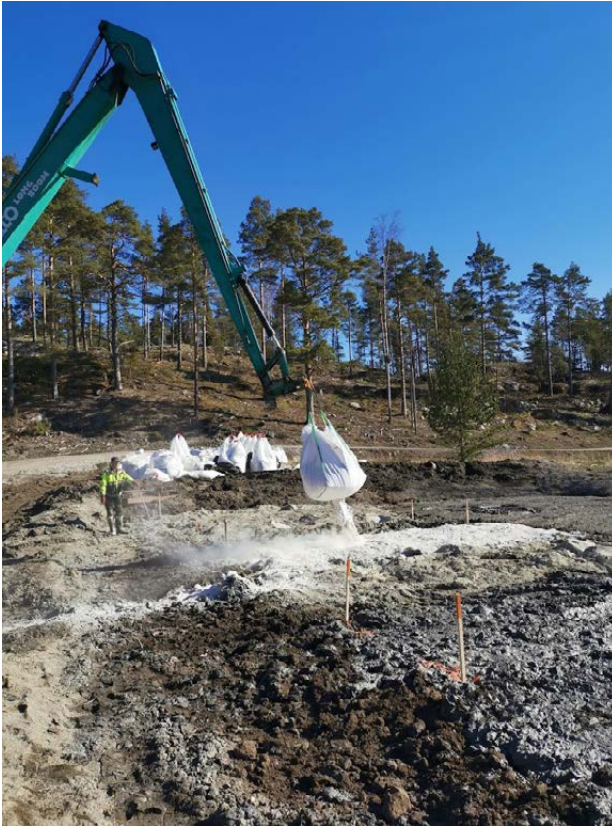
Kuva 19. Sideaineen levitys suursäkistä (vasemmalla) ja koeruutu sideaineiden lisäyksen jälkeen (oikealla).
