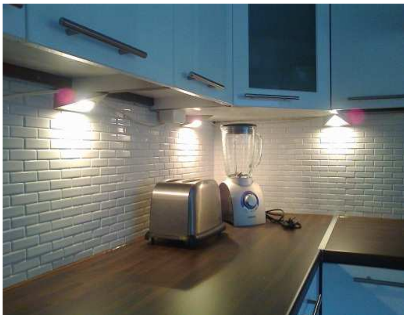
Kuva 5: Keittiön työtason halogenvalet. Kuvassa johtojen kourut eivät ole vielä paikoillaan.
