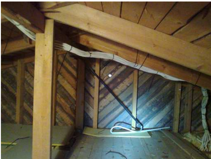
Kuva 18: Keskuselta tulevat syötöt välikaton puolella, kun kaikki kaapelit oli vedetty.
