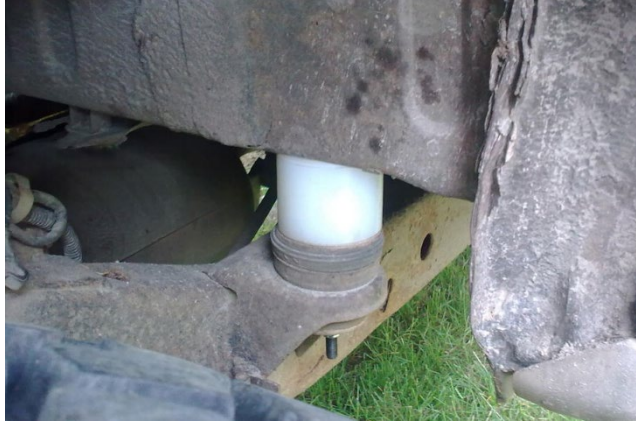
Kuva 11. Korin ja rungon väliin asetettu korotuspala (Offipalsta 2010).
