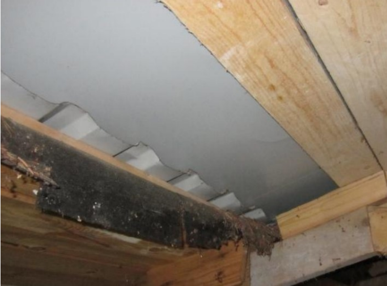
Kuva 19. Vesikate ja aluskatteet yläpohjasta tarkasteltuna.
