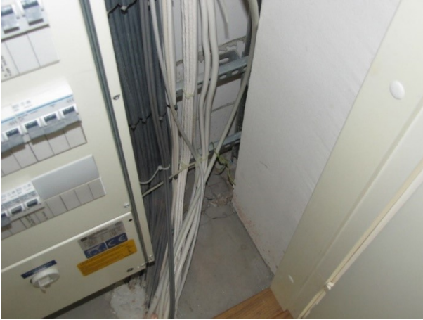
Kuva 27. Rakennusteknisen tilan lattian betonilaatassa on halkeamia.
