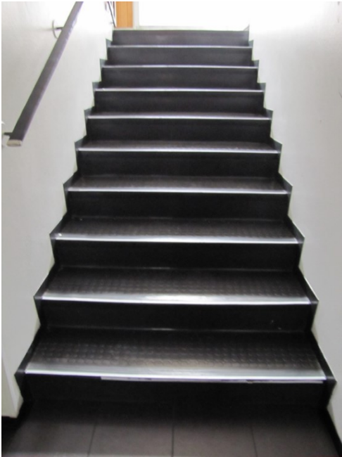
Kuva 22. Toinen rakennuksen pääportaikoista.
