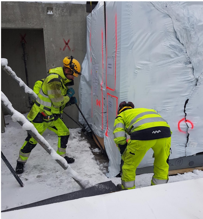
Kuva 9. KPH-Elementin paikalleen mittaus ja asennus käynnissä (Saarinen 2021).
