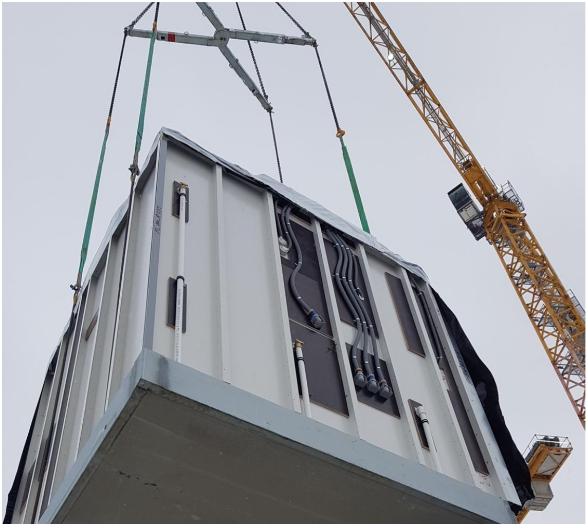
Kuva 6. Nostopuomi ja nostoraudat (Saarinen 2021).
