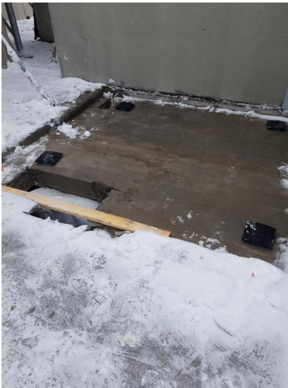
Kuva 8. Elementtivaraus ja korkolaput ontelolaatassa (Saarinen 2021).
