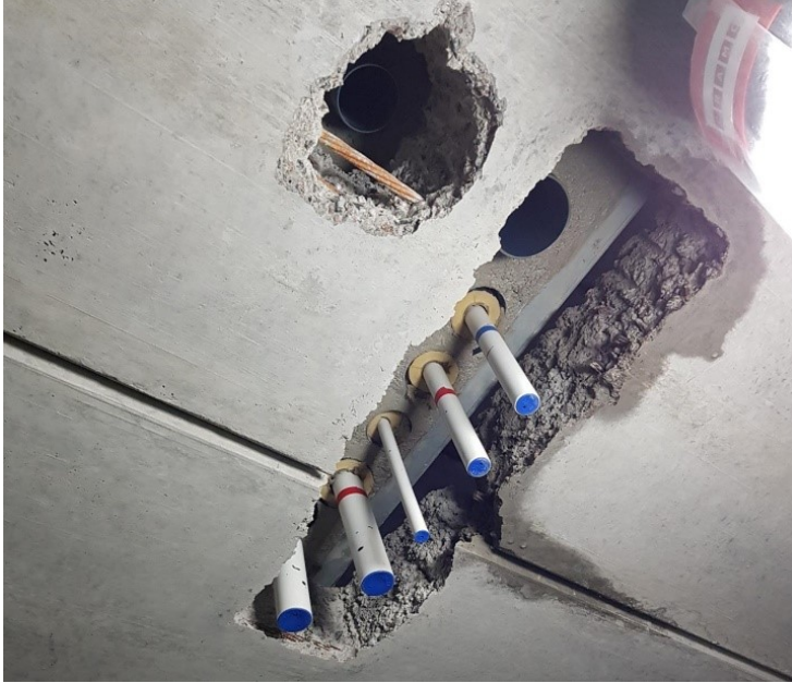
Kuva 7. Talotekniikan varaus ontelossa ja linjojen päät KPH-elementin pohjassa (Bonava 2021).
