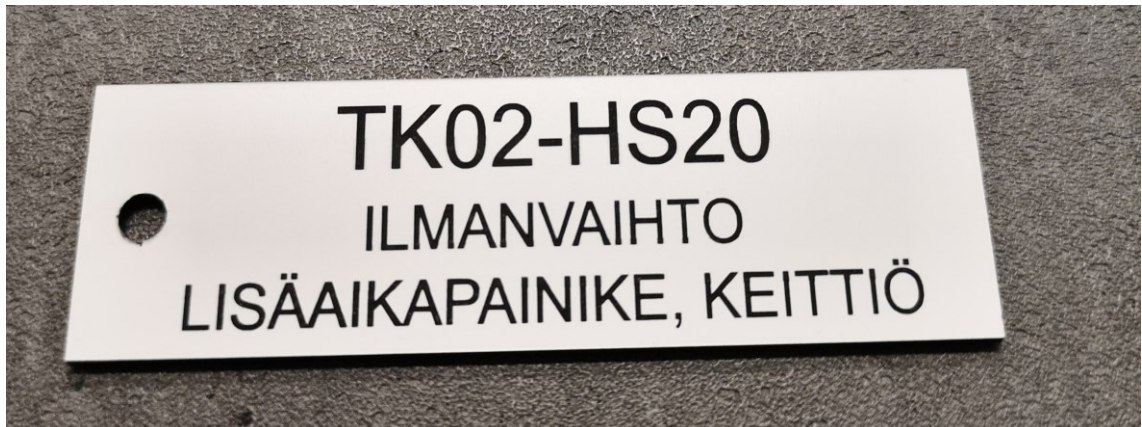
Kuva 9. Osoitekilvessä on järjestelmä- ja laitetunnus, sekä lyhyt kuvaus laitteen toiminnasta, ominaisuuksista sekä vaikutusalueesta.
