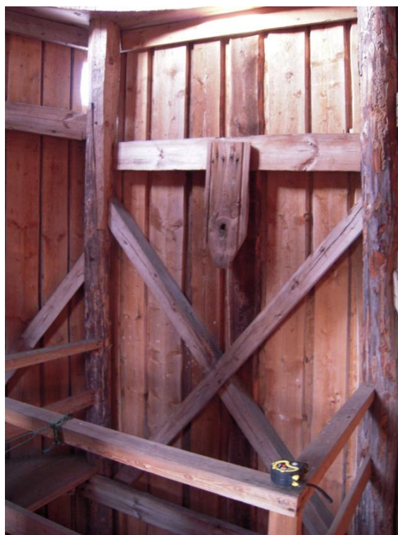
A-seinä ylimmässä kerroksessa
