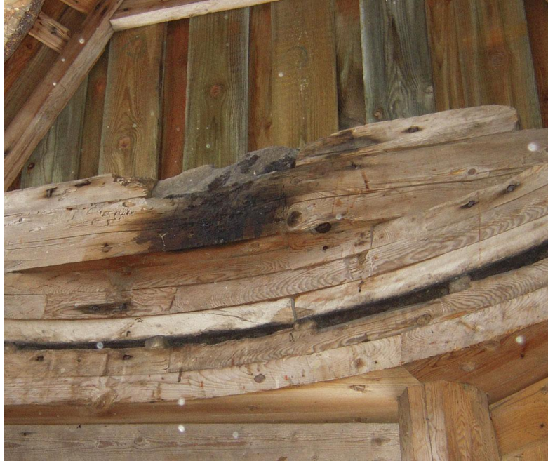
Kuva 7. Eriksnäsin tuulimylly yksityiskohtakuva.
