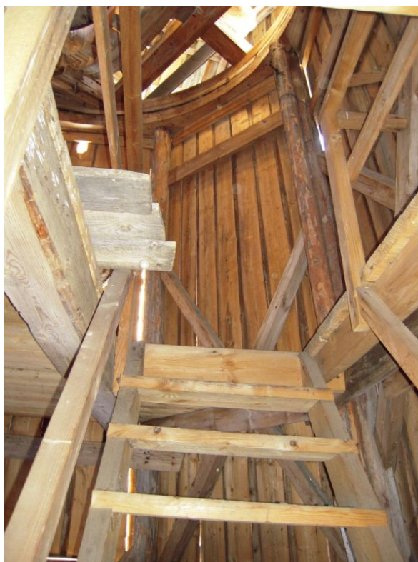
Portaat ylimpään kerrokseen
