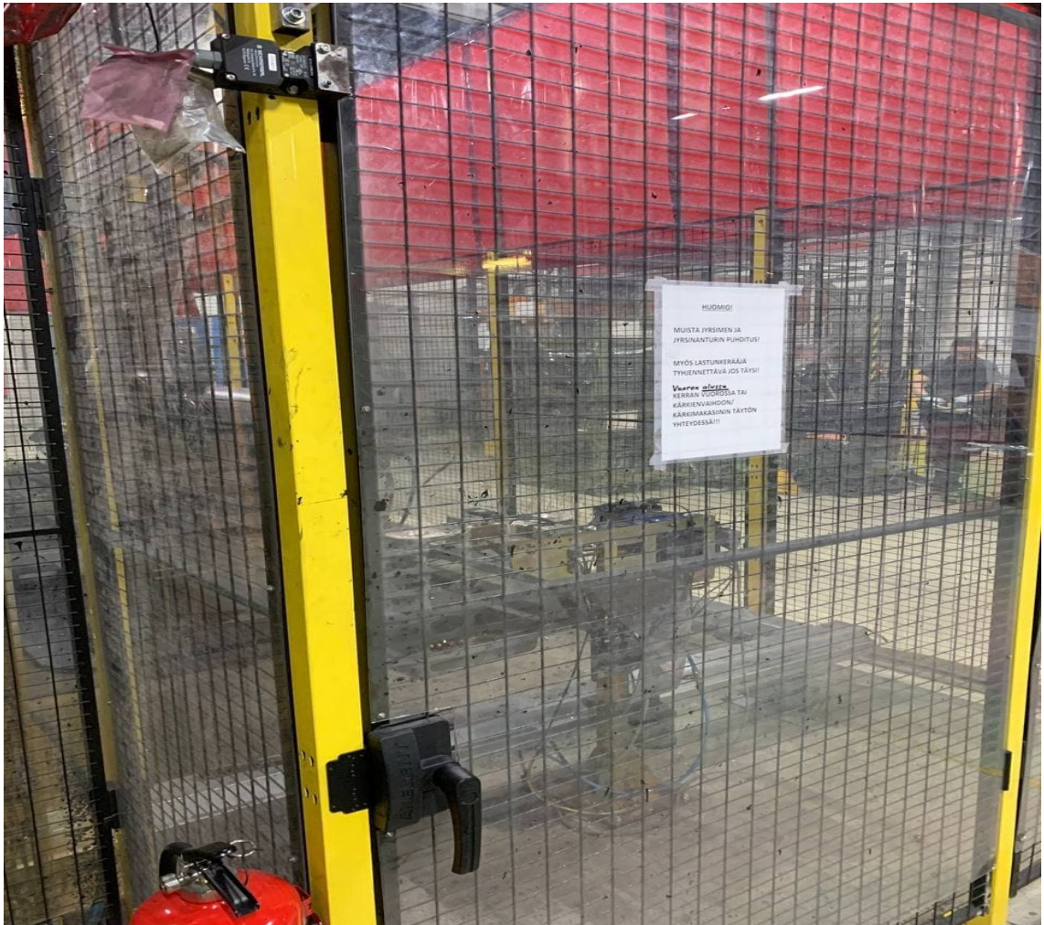
Kuva 15. Solun toinen käyntiovi.
