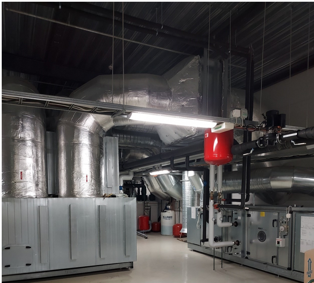
Kuva 9. Kankaanpään K-Citymarketin ilmanvaihdon laitteistotila
