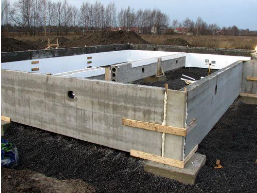
Kuva 1 Perustuselementeistä ja ontelolaatoista perustukset ja alapohja valmistuvat nopeasti. Perustukset valmiina odottamassa ontelolaattojen asennusta.
