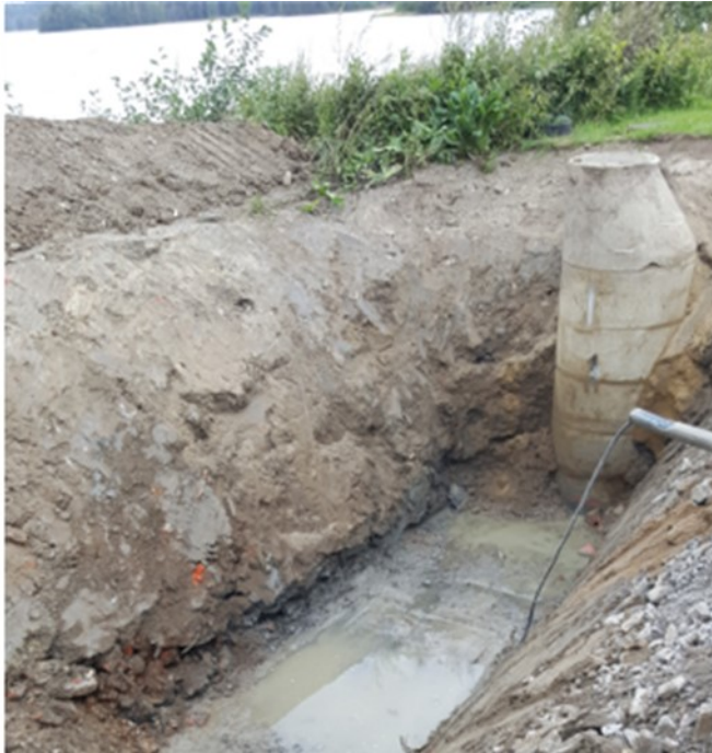
KUVA 1. Putkikaivanto
