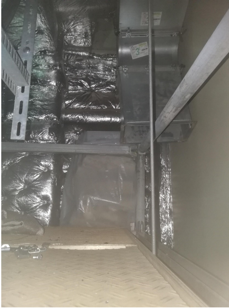
Kuva 12. Purettu ilmanvaihtokanava läpiviennin poiston ajaksi. (Meyer Turku Oy, 2021.)
