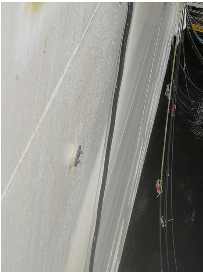
Kuva 11. Poistettava läpivienti laivan kyljessä. (Meyer Turku Oy, 2021.)
