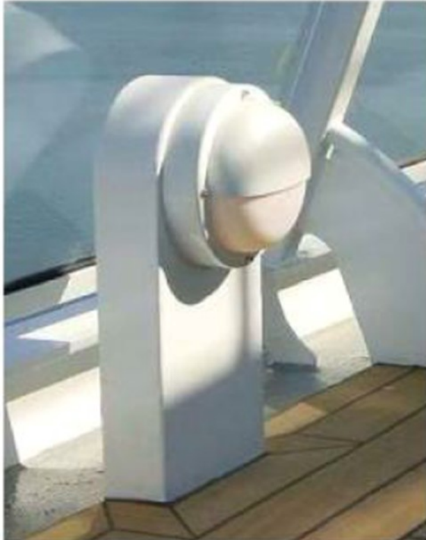
Kuva 8. Bollard-valaisin. (Meyer Turku Oy, 2021.)
