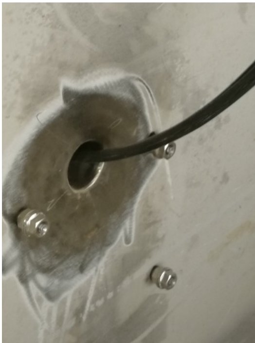
Kuva 9. Bollard-valaisimen sähköläpiviennin oikeaoppinen asennus. (Meyer Turku Oy, 2021.)
