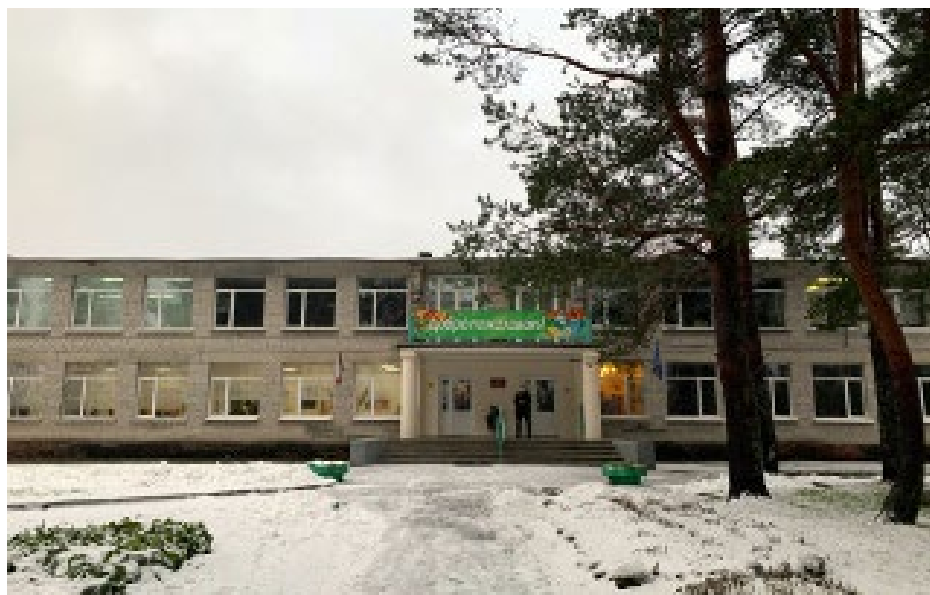
Фото 1. Здание Житковской школы
