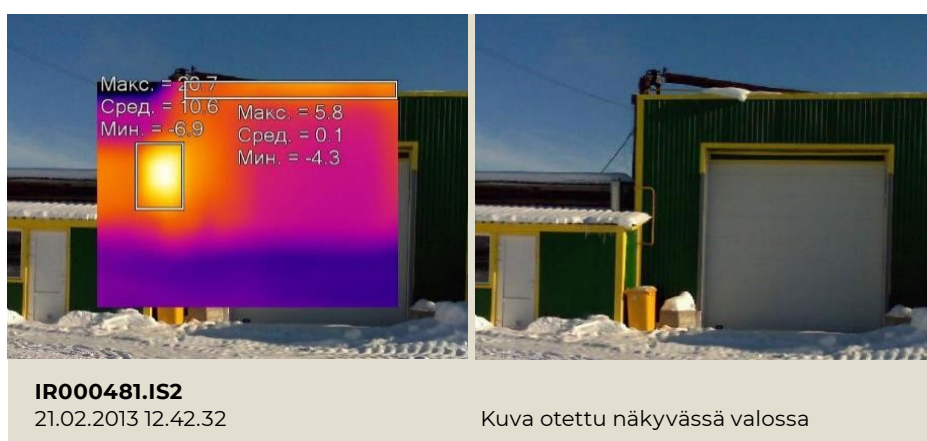
РИСУНОК 3. Здание гаражно-ремонтного бокса
