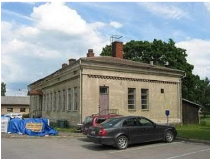
Kuva 14. Eteläisen pään ikkunat ja käyntiovi. (Kuva Satakunnan Museon inventointiraportista).
