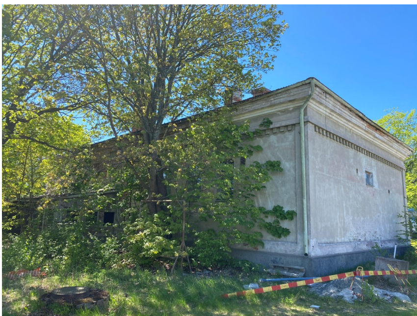
Kuva 4. Rakennuksen piha-alueen rehevöitynyt kasvillisuus.
