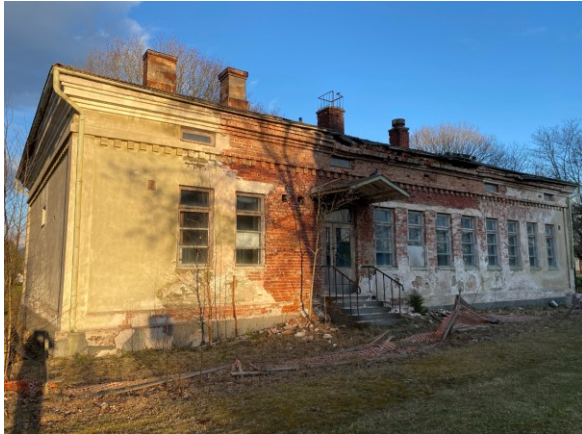
Kuva 13. Läntisen puolen ikkunat ja käyntiovi.
