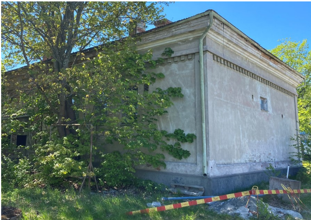
Kuva 12. Rakennuksen varjoisilla puolilla julkisivut ovat pintapuolisesti kohtuullisessa kunnossa. Kuvassa näkyy myös hammaskoristeinen kerroslista.
