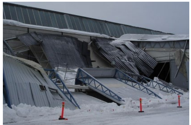
Säännölliset tarkastukset takaavat rakennuksen turvallisuuden (Länsi-Uudenmaan pelastuslaitos)
