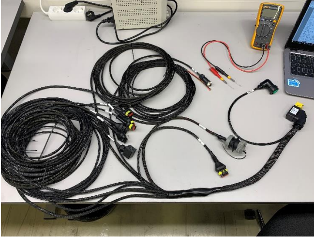
Kuva 3. Johtosarjan testaaminen yleismittarilla (2)
