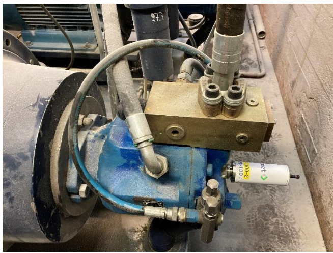
Aksiaalisuuntainen mittaus Rexrothin aksiaalimäntäpumpusta
