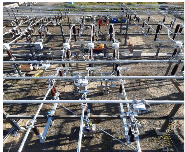
Kuva 2. Ilmaeristeinen ulkokytkinlaitos
