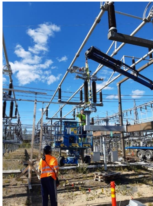
Kuva 3. Tartuntaerottimen asennus
