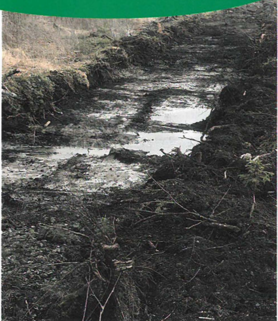
Koneyrittäjän tekemä rakenne tulen leviämisen estämiseksi.
