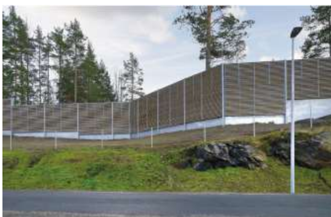
Kuva 17. Urakointiasennus M.Rautio Oy:n valmistama meluste Savonlinnan ohitustielle (Urakointiasennus M.Rautio Oy 2015, 3).
