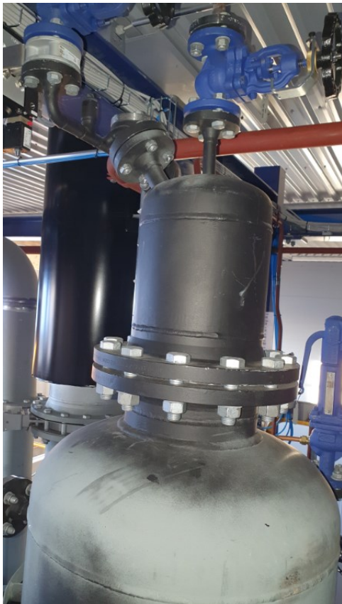
Kuva 5. Training Centren Dearatori ja Feed water tank (kuvannut Robert Silvendoin).
