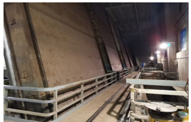
Jylhämän vesivoimalaitoksen luukkusali ja sen tuloputken luukut
