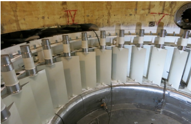
Kuva uusien johtosolukkeiden asentamisvaiheesta
