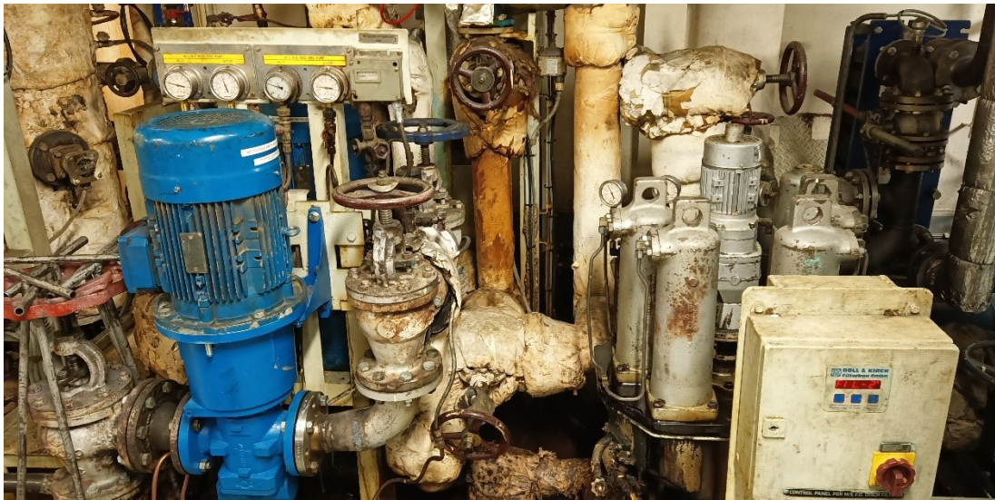
Kuva 15 Pääkoneiden polttoaineenkiertopumput (matkustaja-autolautta)
