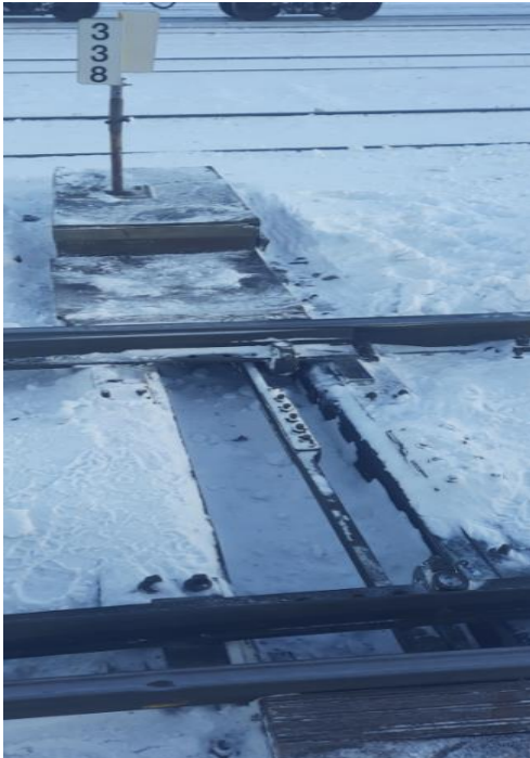
(Kuva 13 koneharjauksen jälkeen puhdistettu tankomonttu)
