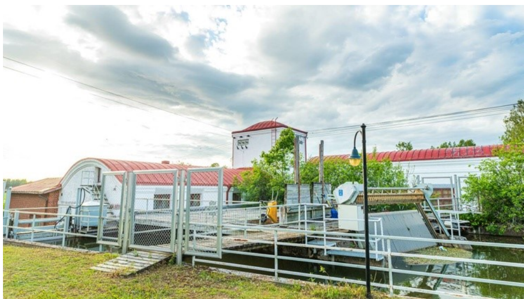
Kuva 1 Paneliankosken Voiman vesivoimalaitos Paneliassa (Paneliankosken Voima)
