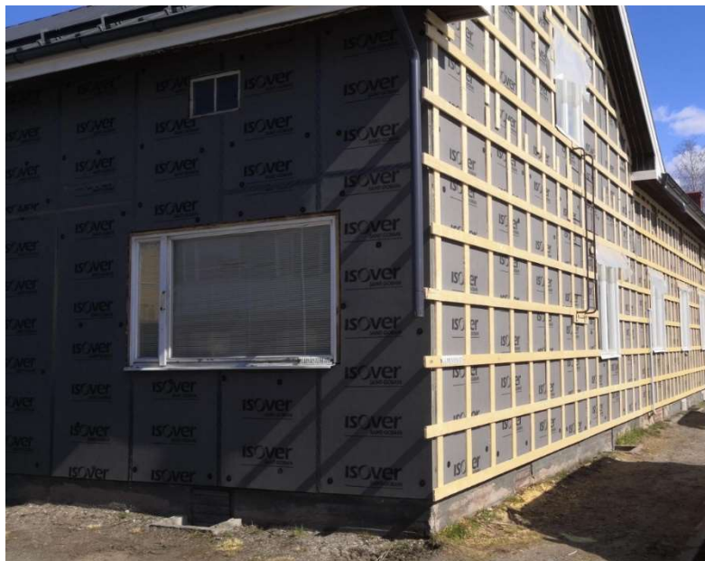
Kuva 15. Tuulensuojalevyt asennettuna ja ristiinkoolaus toisella sivulla.
