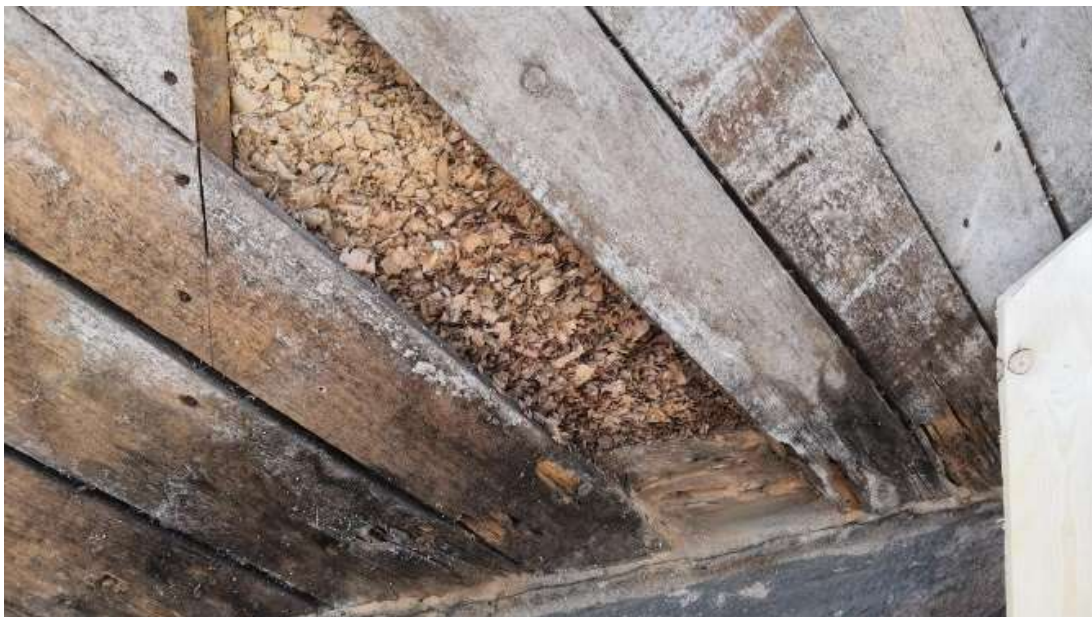
Kuva 12. Homeisten lautojen vaihtaminen ja sahanpuru.
