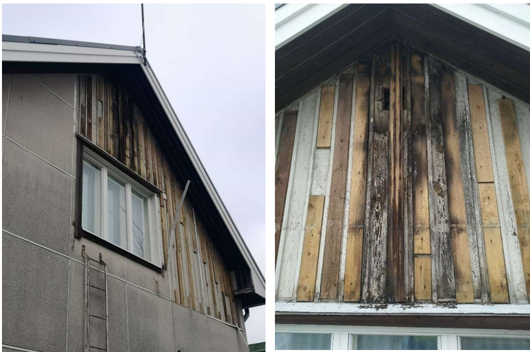
Kuvat 10 ja 11. vaurioitunut lauta, karaattilevyn alta
