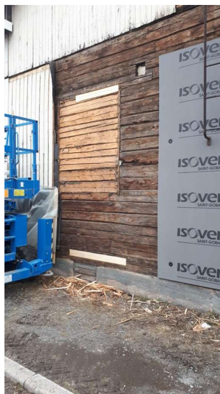
Kuva 17. Vanha ikkunapaikka laitettu kiinni
