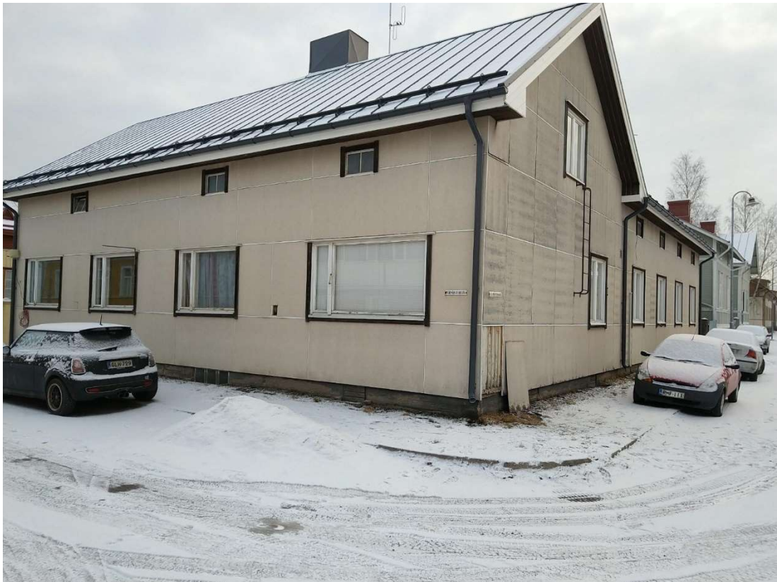
Kuva 2. Porissa sijaitseva rakennus, johon tehtiin julkisivun uusiminen alkuvuonna 2021
