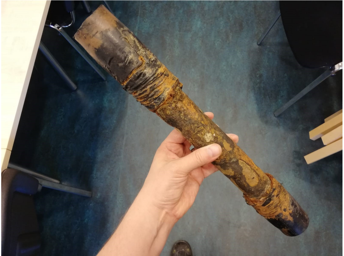
Kuva 1. Vanha tonttijohdon osa, joka löytyi saneeraustöiden yhteydessä Ykspihlajasta.
