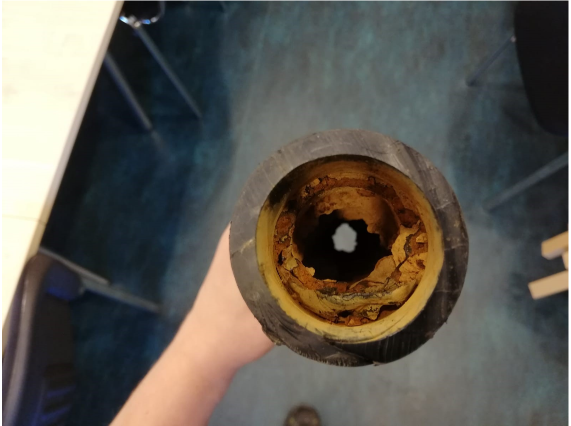
Kuva 2. Vanha tonttijohdon osa, joka löytyi saneeraustöiden yhteydessä Ykspihlajasta.
