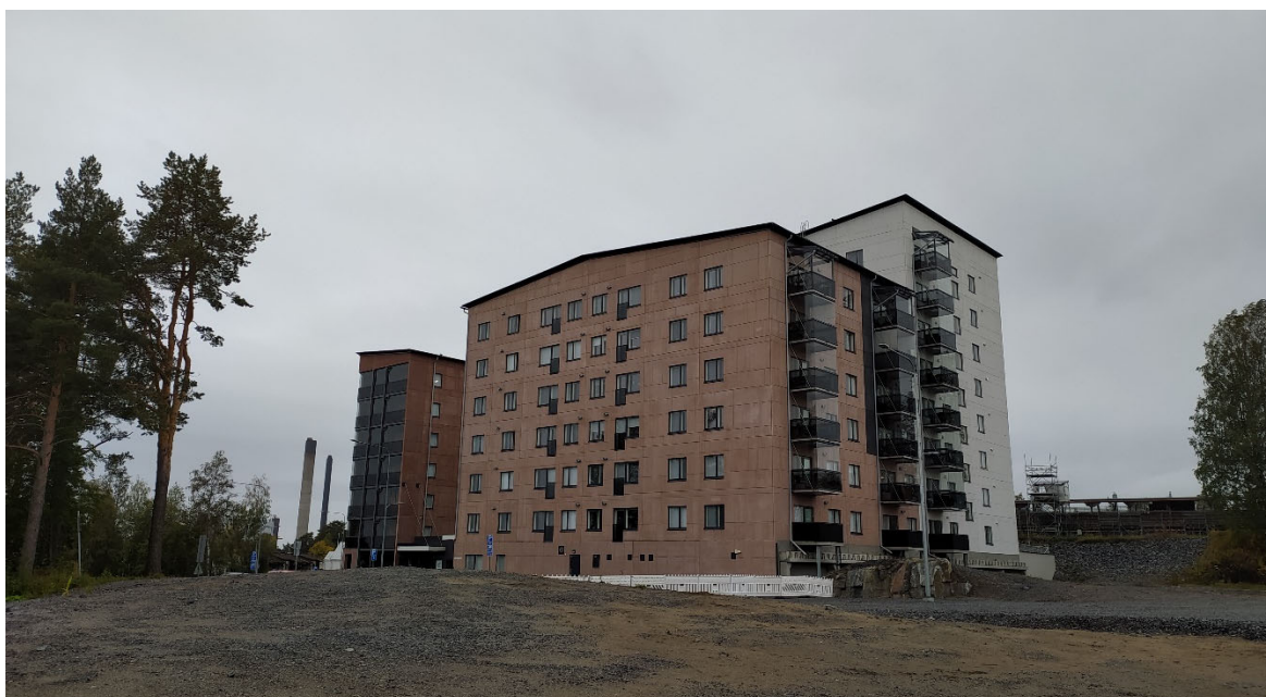
KUVA 5. Mölymäen uutta rakennuskantaa (Kuhmonen 2021, CC BY-NC-ND)
