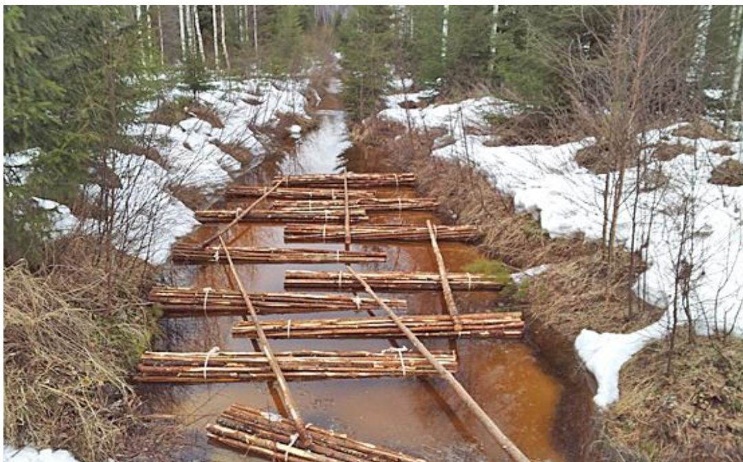
Kuva 8. © Esko Keskinen. Kuusenrangoista on tehty nippuja, joita on asennettu laskeutusaltaaseen [14]
