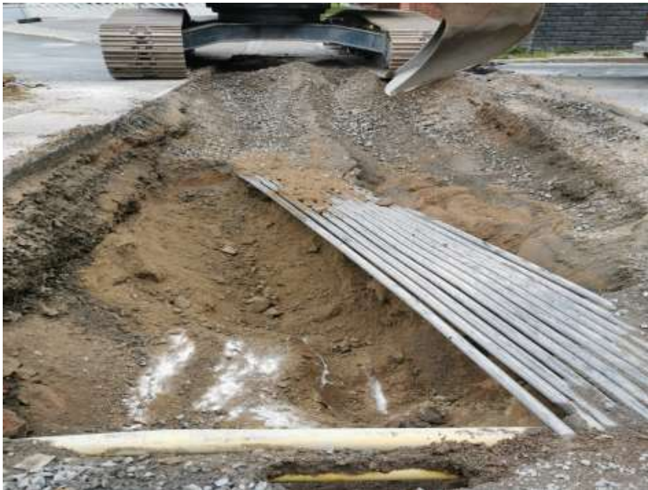
Kuva 5. Työmaalta löytynyt kellarin seinä
