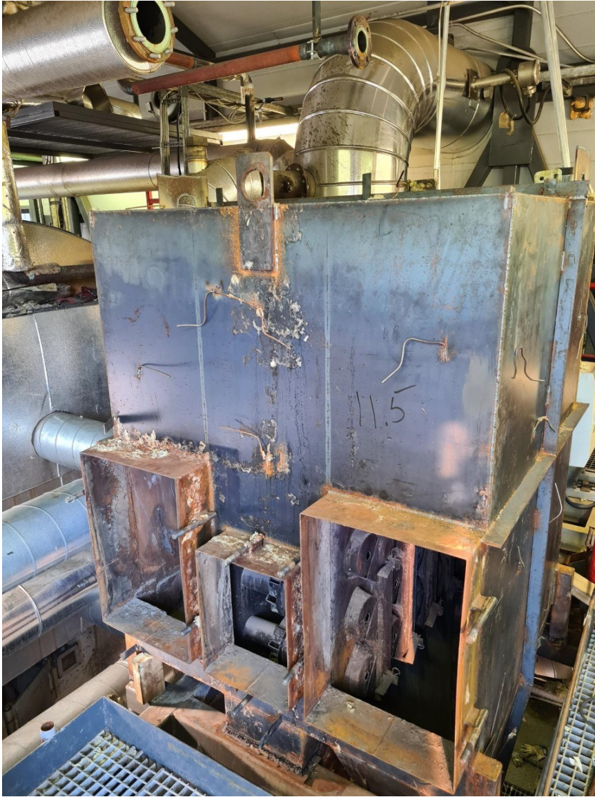
KUVA 10. Kärsämäen KPA-kattilan vanha multisykloni
