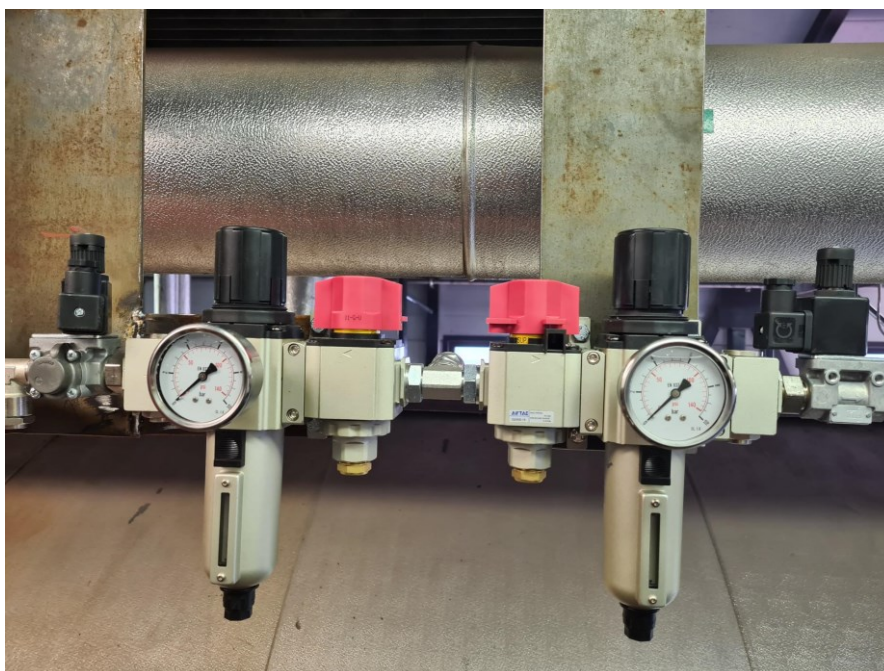
KUVA 22. PCG-paineilmalaitteisto
