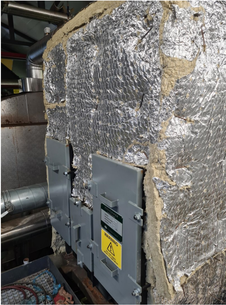
KUVA 17. Multisykloni eristettynä
