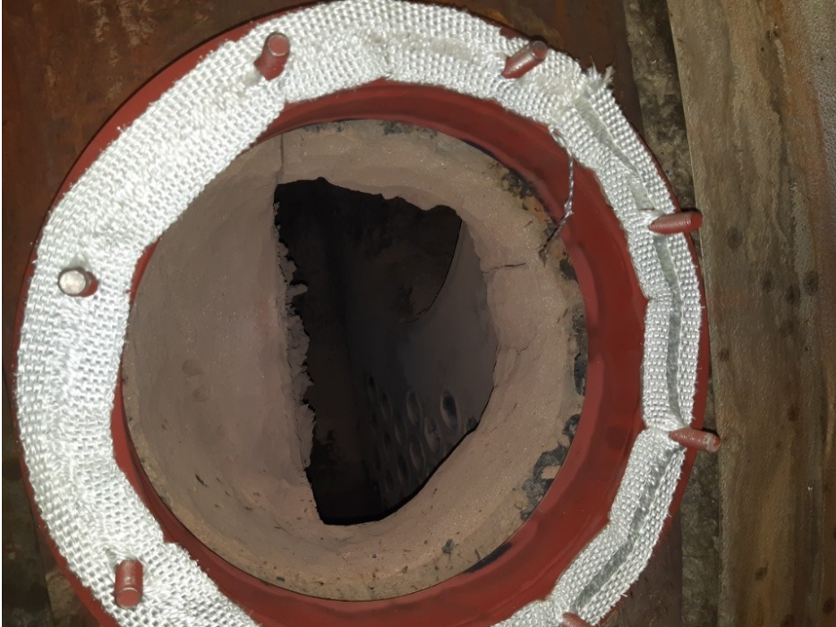
KUVA 24. Ääninuohoimen asennusreikä
