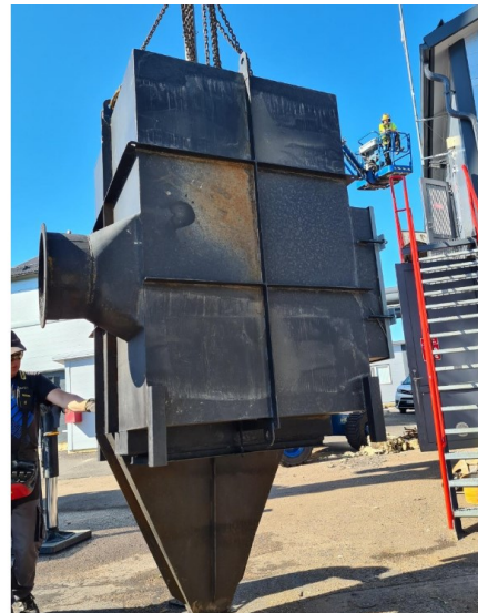
KUVA 9. Kuvassa vasemmalla uusi multisykloni edestäpäin ja oikealla nostettuna oikeinpäin
