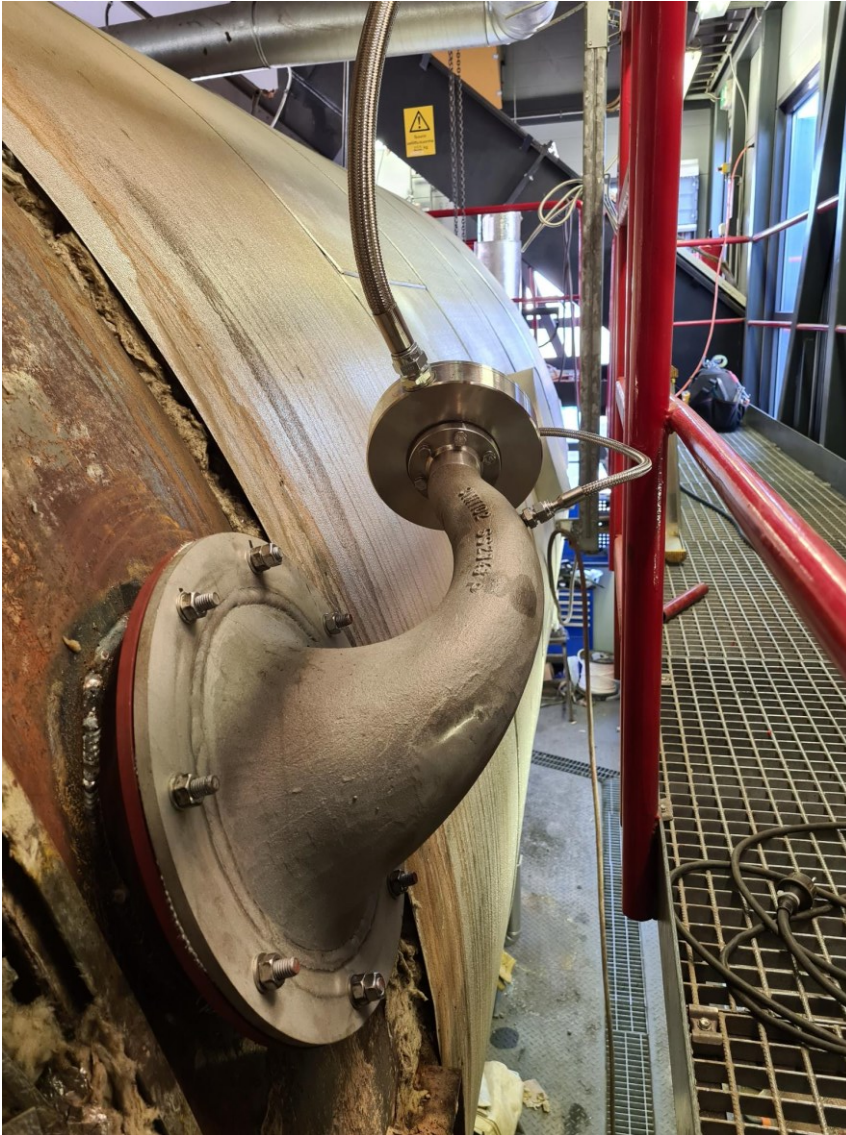
KUVA 25. Ääninuohoin paikalleen asennettuna
