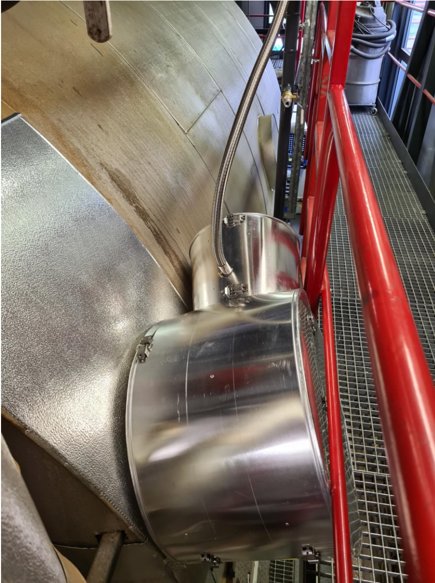
KUVA 26. Ääninuohoin käyttövalmiina
