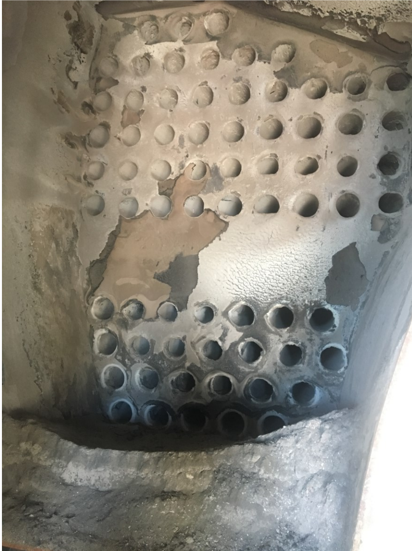
KUVA 23. Tuliputket kääntökammiosta kuvattuna
