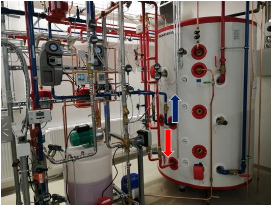
KUVA 7. Aurinkokeräinjärjestelmä kokonaisuudessaan lukuun ottamatta keräimiä
