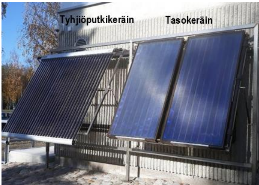
KUVA 8. Hybridilaboratorion seinustan tyhjiöputki- ja tasokeräimet (15)
