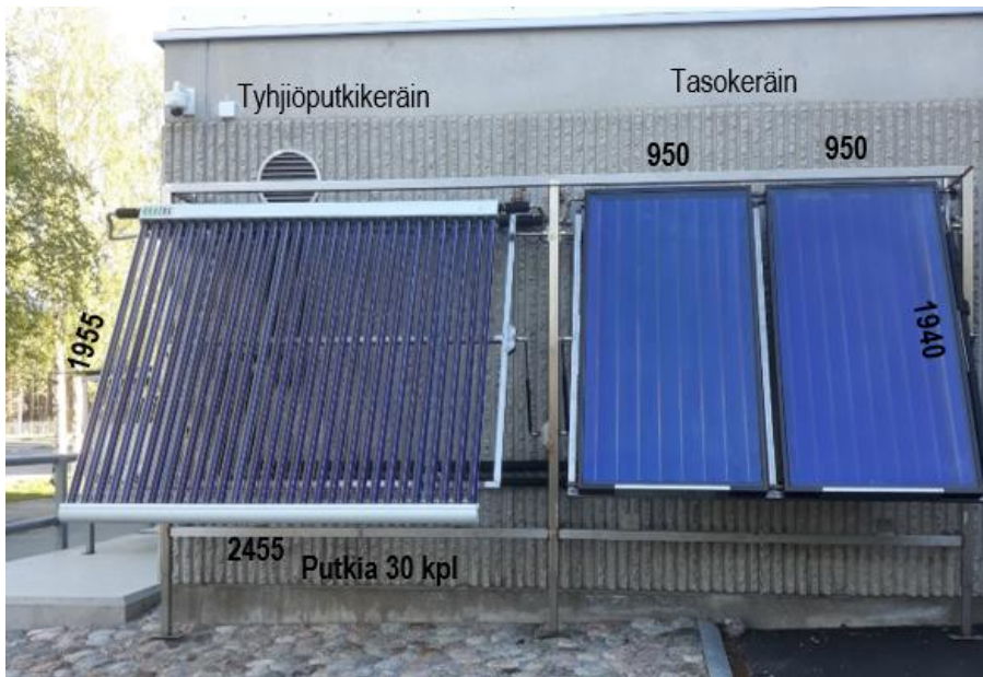
KUVA 5. Tyhjiöputki- ja tasokeräimen mitat (15)
