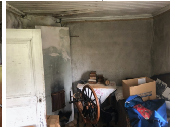
Yleiskuva itäseinän suuntaan
