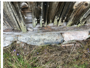
Eteläseinän alaosa on paikoin lahonnut ja hirsiseinä patistaa takaa
