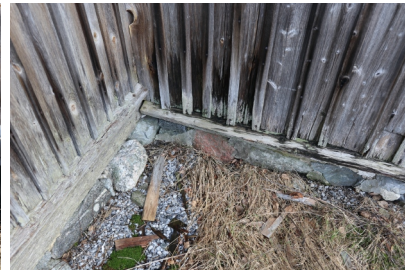
Kuistin eteläseinän ja torpan länsisivun perustusta
