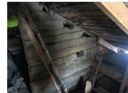
Puodin ja porston välisen hirsipäätykolmion naulattu sidepuu
