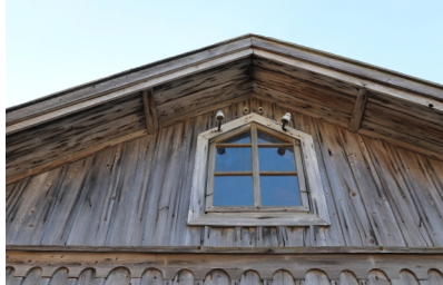
Pohjoispäädyn harjakolmiossa eri leveysisiä lautoja
