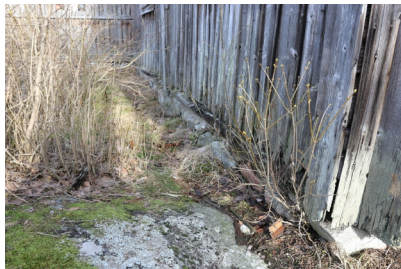
Lounaisnurkalta kuvattuna länsisivun perustuksia
