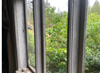
Tuvan ikkunoissa on välipuitteettomat urapuitteet
