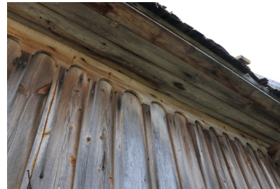
Länsisivun pohjoispäässä pari haapalautaa
