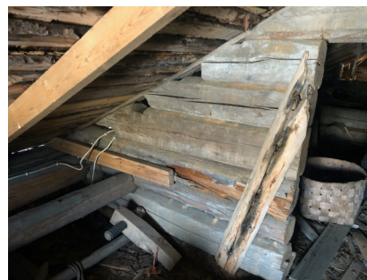
Vuoliaiskattorakenteesta muistuttavat lovet katonrajassa
