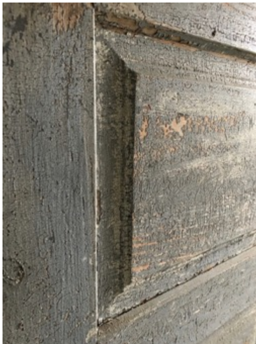
Kuva 46. Krakeloitunutta pellavaöljymaalipintaa (Lindholm 2021)
