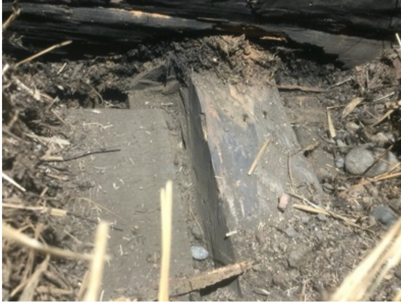
Kuva 20. Tuvan vanhat laipion laudat ovat t-haljaspuolikkaiden päällä kannatuksella (Lindholm 2021).
