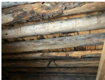
Ruoteet on tuppeensahattua pintalautaa
