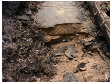
Läpi asti labonnut kohta laudoituksessa ja paneloinnissa
