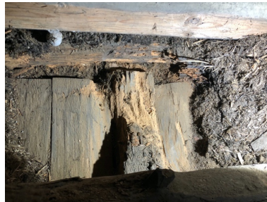
Ansaksen ja pihan puoleisen hirsiseinän liitoskohta
