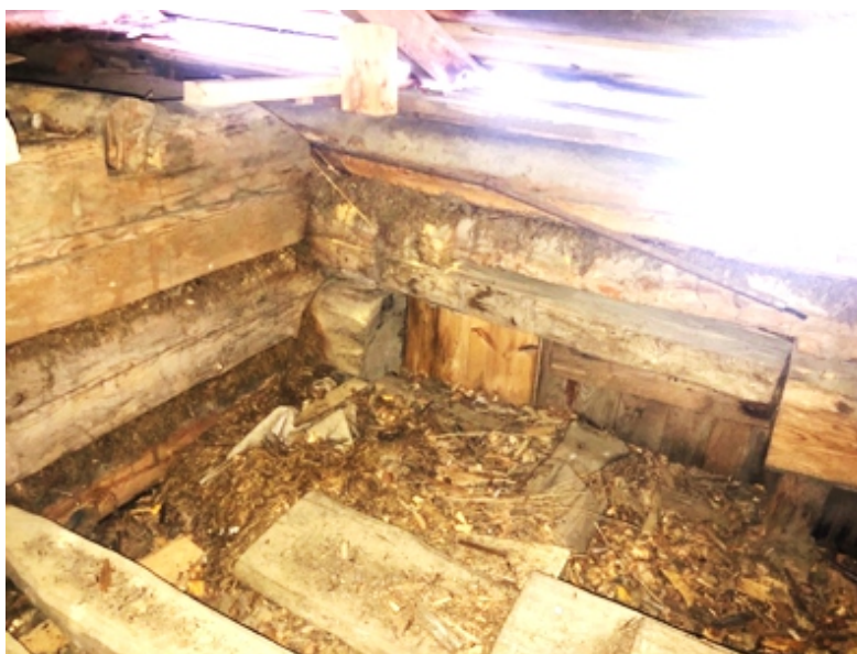
Kuva 15. Länsiseinän konsolihirsi (Lindholm 2021)
