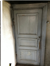
Tupaan johtava ovi täysranskalaisin peiliprofiloinein
