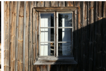
Eteläseinän pamarin ikkuna
