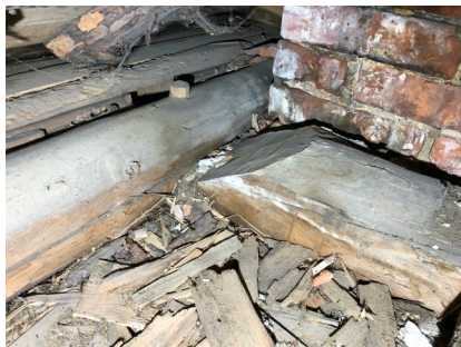
Tuvan hirsirungon pohjoisseinän ylimmän hirren päissä myös viisteet, oikealla kuvassa näkyy myös konsolirakennetta
