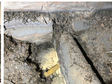
Niska tuntui olevan labo alapuolelta vain toiselta puoleltaan
