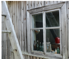
Kuistin pohjoisseinän ikkunat
