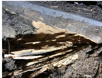
Labonnutta niskan alapintaa
