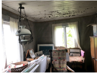
Yleiskuva sisäpihan länsiseinän suuntaan
