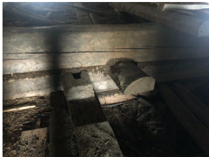
Porstokamarin hirsiseinä liittyy tuvan hirsirunkoon karaliitoksella
