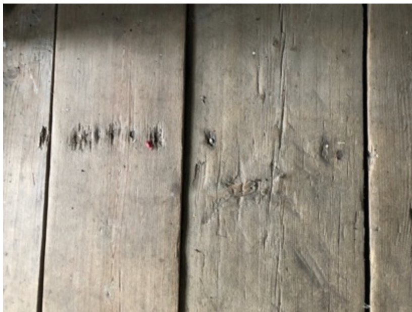
Kuva 25. Käsittelemätön kulunut mäntylankkulattia (Lindholm 2021)
