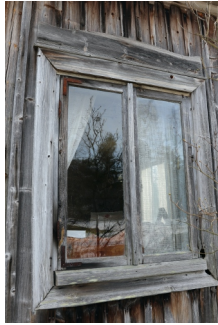
Tupakamarin länsisivun ikkuna
