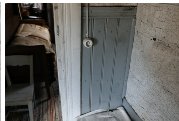
Pistorasiat on asennettu myös pintaan
