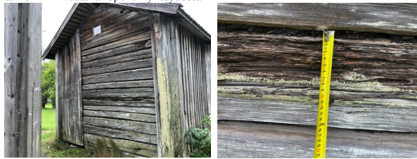
Itäpäädyn eristeisiä paikallisia hirsilahovaurioita
