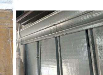
Puolipaneloinnin maalin kiiltoa
