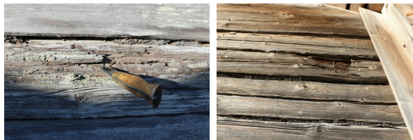
Itäpäädyn eristeisiä paikallisia hirsilahovaurioita
