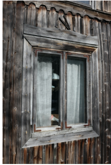
Tupakamarin eteläpään ikkuna
