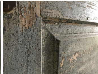
Kauniisti krakeloitunutta pellavavälymaalipintaa
