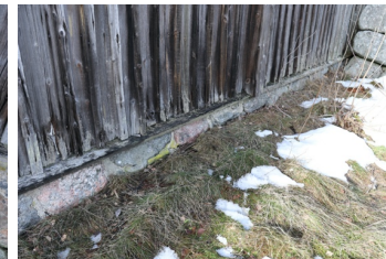
Itäseinän ulkoverhouksen alapään vaurioita vesilistassa ja pystyrimaluodituksen alapäässä
