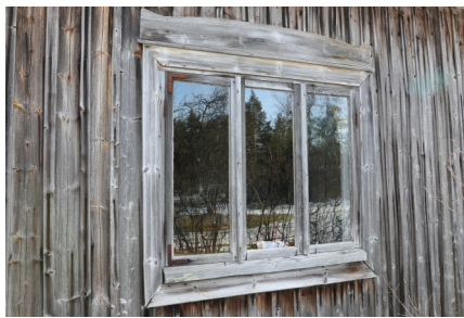
Tuvan länsisivun välipuitteeton urapuiteikkuna
