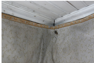
Seinä- ja kattopintoja
