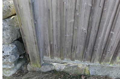
Pohjoispäädyn kuusilautoissa näkyy edelleen sahausen jälkiä
