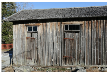
Eteläseinän ovia ja ikkunoita
