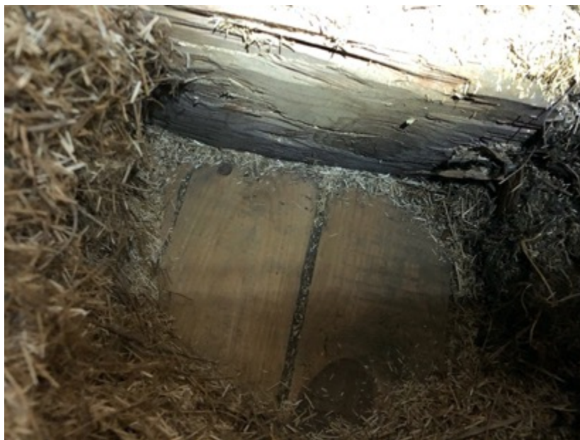
Kuva 19. Porstokamarin mäntypaneeleissa on pontit (Lindholm 2021)
