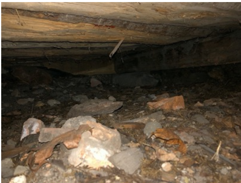
Kuva 17. Porston ryömintätilan pääsi tarkastamaan (Lindholm 2021)
