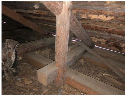
Ruotsalaista kattotuolirakennetta
