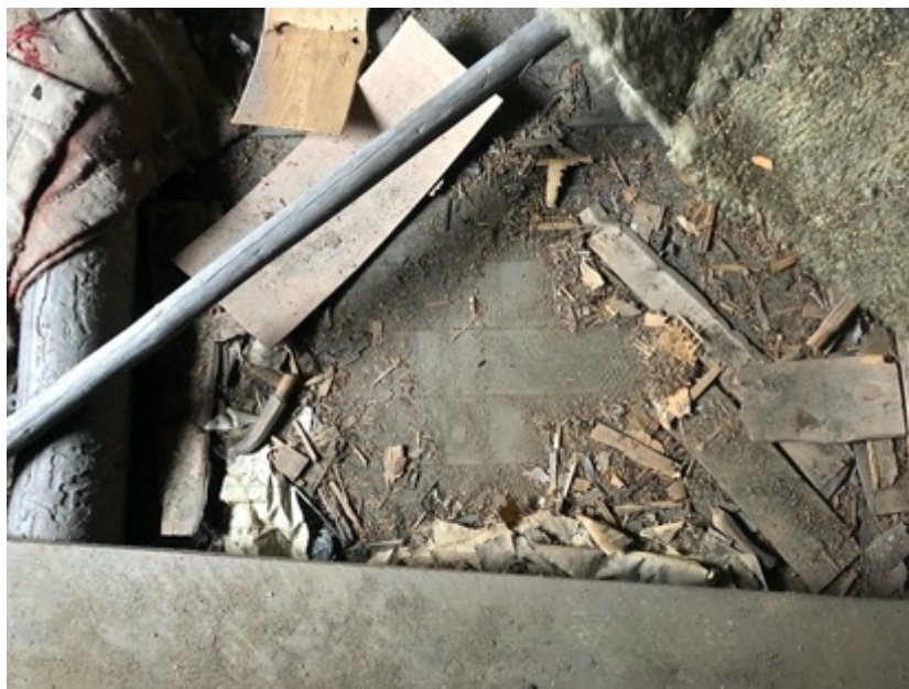
Kuva 18. Puodin yläpohja on eristeetön (Lindholm 2021)
