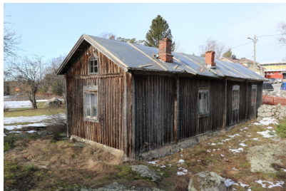
Itäisivun vaihtelevakorkuinen perustus
