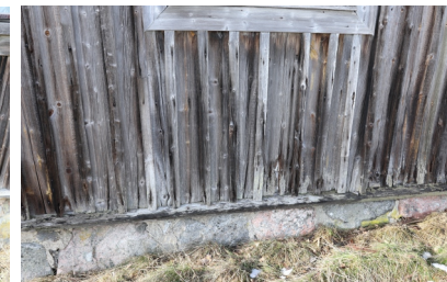
Tuvan itäsvun ikkunan alla pilkkottaa kosteuseristyksenä tuohi
