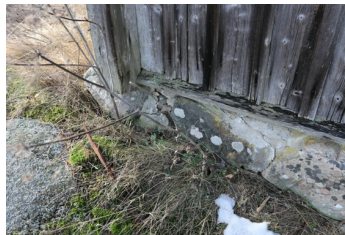
Itäseinän ulkoverhouksen alapään vaurioita vesilistassa ja pystyrimaluodituksen alapäässä
