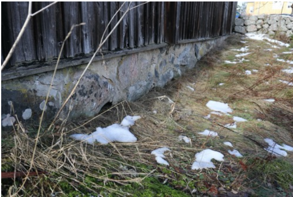
Kuva 12. Itäsivun perustusta (Lindholm 2021)
