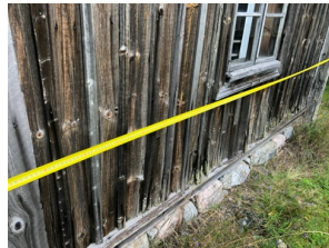
Eteläseinän alaosa on paikoin lahonnut ja hirsiseinä patistaa takaa
