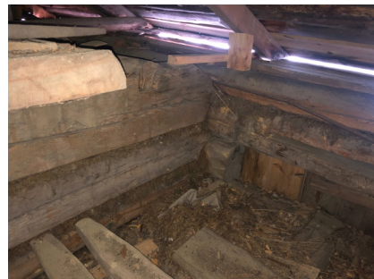
Tuvan hirsirungon pohjoisseinän ylimmän hirren päissä myös viisteet, oikealla kuvassa näkyy myös konsolirakennetta
