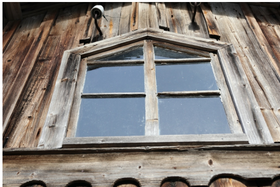
Eteläpään vintti-ikkuna myös asennettu suoraan hirsirunkoon ilman karmia
