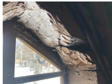
Vintin ikkuna-aukkoja on veistetty kirveellä
