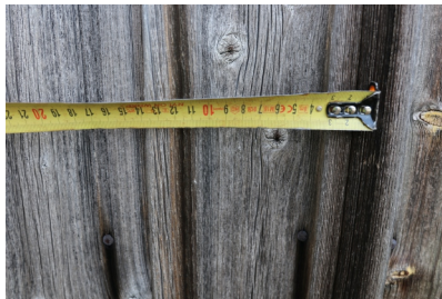
Länsisivun vaihtelevaleveyistä ulkoverhouslaudoitusta
