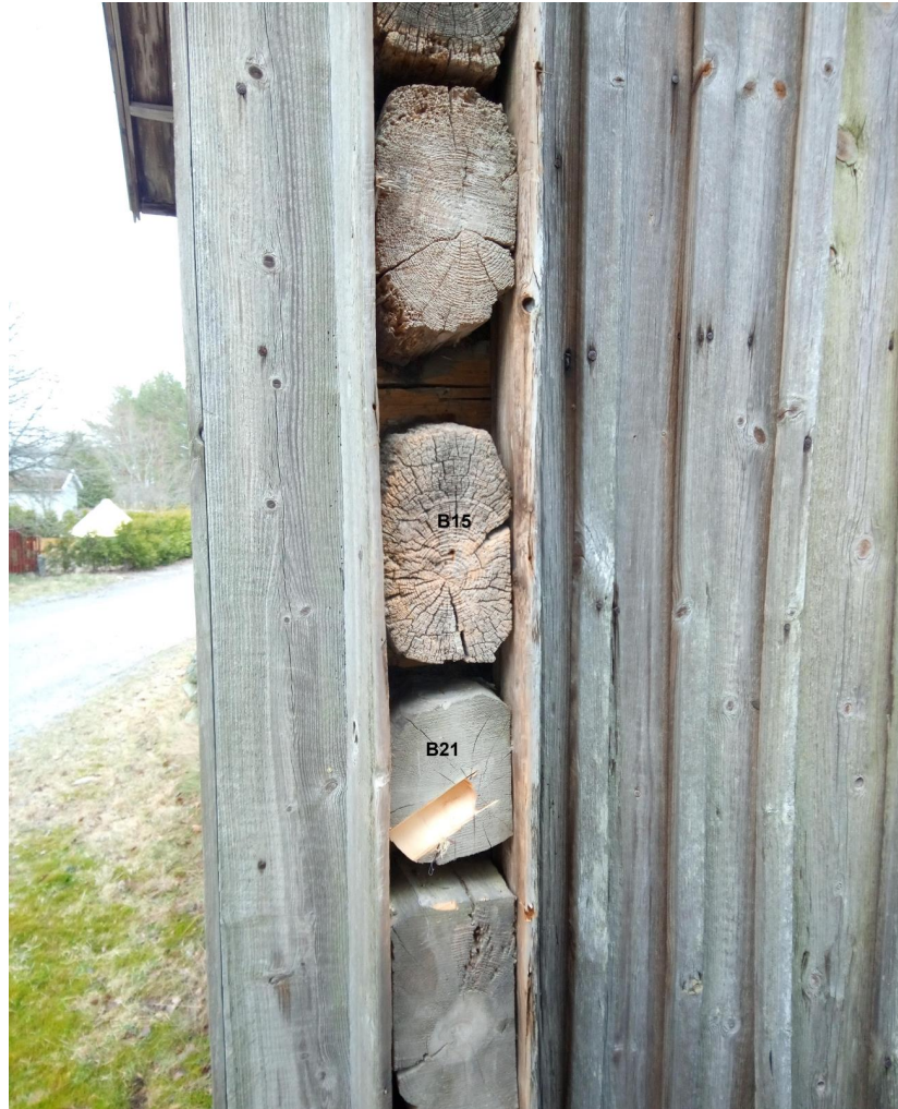
Kuva 1. Laihosen torpan B-osan pohjoisseinä. Kuvaan on merkitty hirret, joista näytteet B15 ja B21 ovat peräisin. Sulkanurkkainen hirsi (B15) on selvästi enemmän säänsyömä, kuin sen alla olevat hirret.
