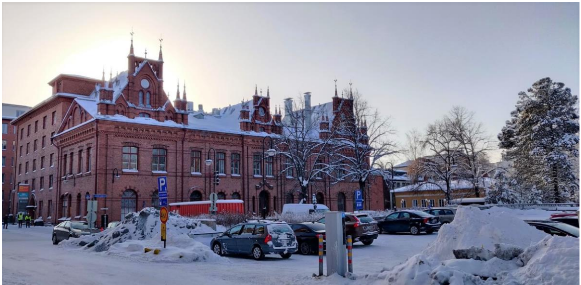
KUVA 14. Suunnittelualueen eteläpuolella sijaitseva rakennus ja suunnittelualueella oleva nykyinen pysäköintialue (Kaihari, 2021)
