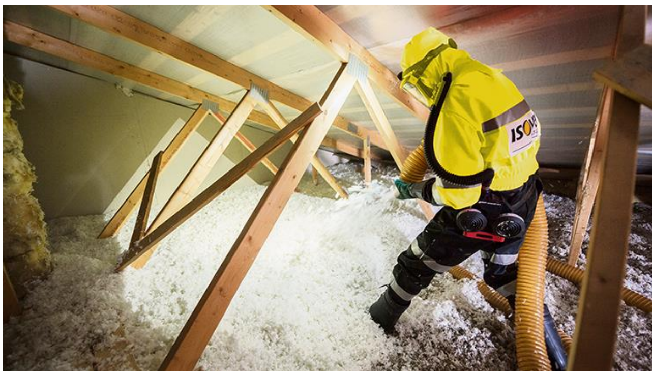
Kuva 2. Yläpohjan lisäeristys (Rakentaja.fi, 2021)
