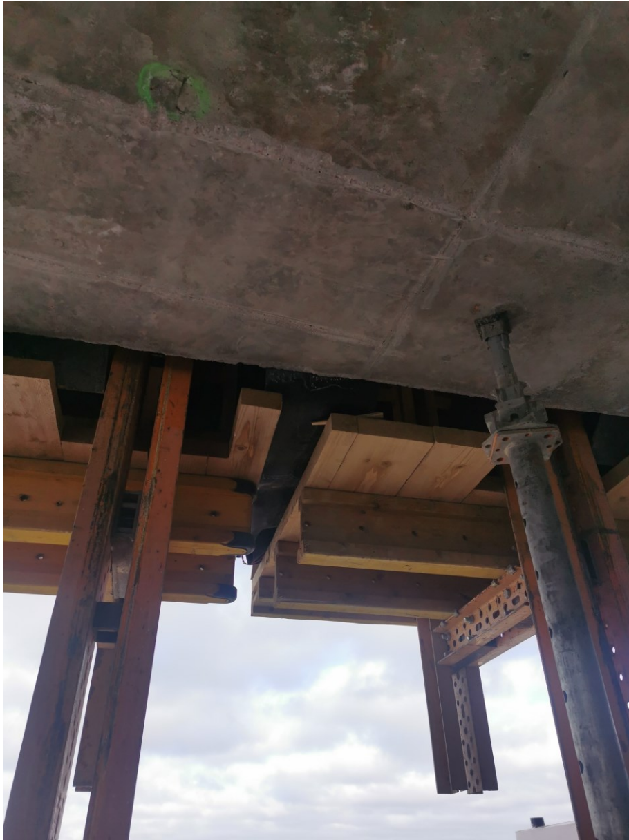
Kuva 2. Kiipeävä tuulensuojaseinän lattia taso
