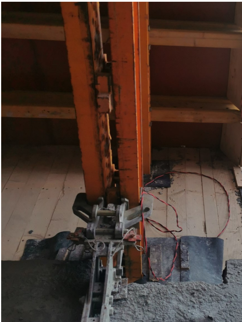
Kuva 3. Tuulensuojaseinän kiskon tiivistys paksulla kumimatolla.
