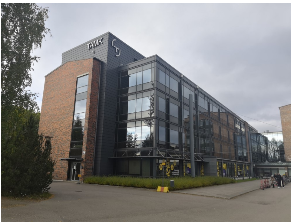
KUVA 6. Tampereen ammattikorkeakoulun pääkampuksen C-talo
