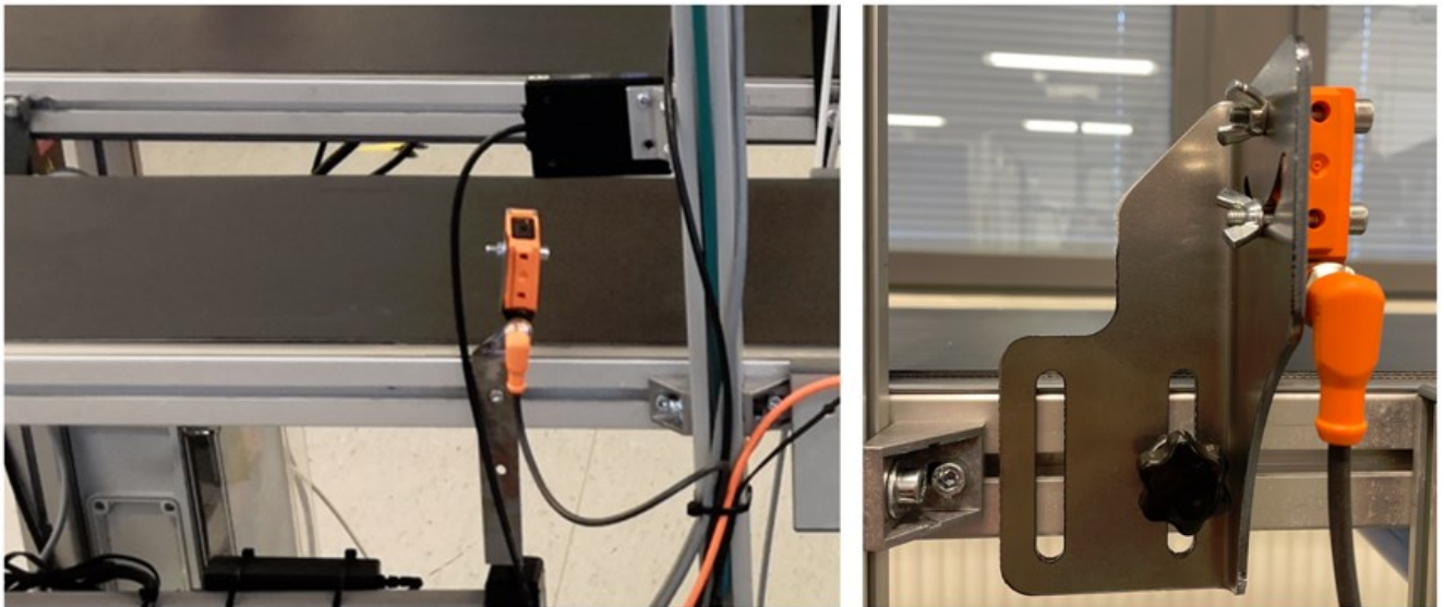
Kuva 28. Älykamerapisteen valokennon kiinnitys ennen ja jälkeen muutoksen
